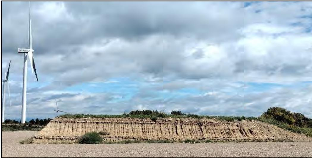
**Fotografía 12.** Desmorte de escasa altura con procesos erosivos activos
