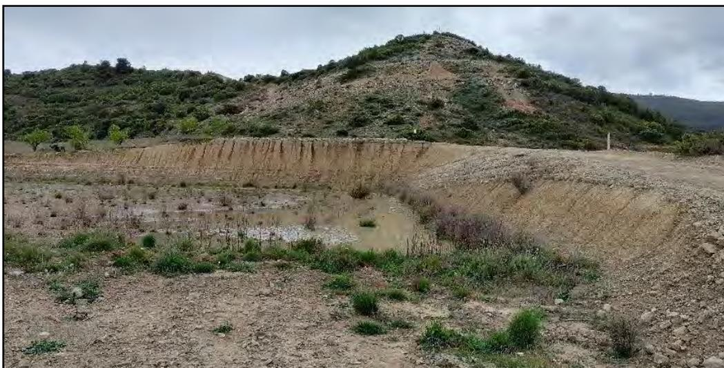
**Fotografía 14.** Talud con procesos erosivos activos en LP11
