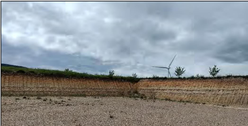
**Fotografía 16.** Desmontes junto a la turbina LP09 con erosión por escorrentía
