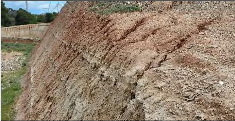
**Fotografía 17.** Ligeras escorrentías junto a la turbina LP10
