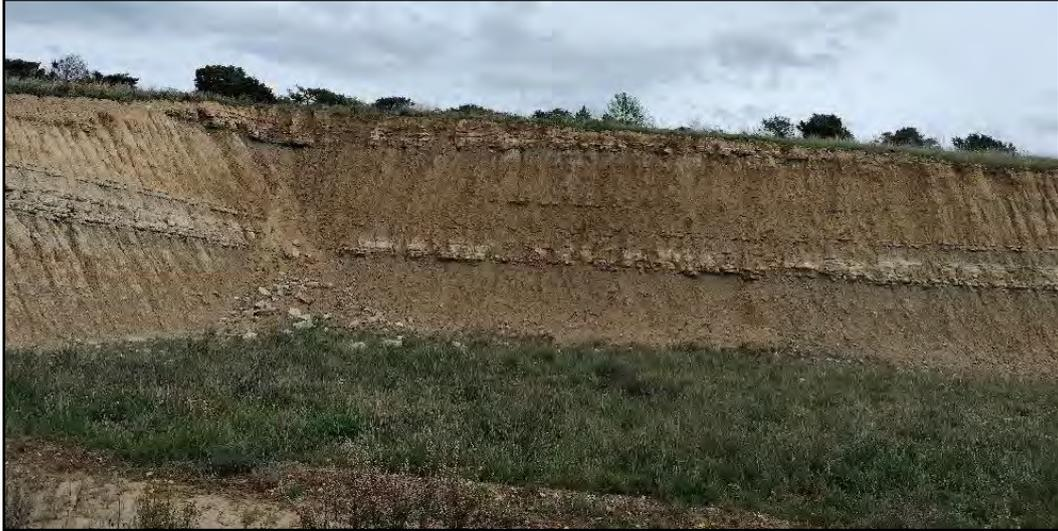
**Fotografía 8.** *Desmante en la turbina LP04 con regueros y siembra exitosa a sus pies*
