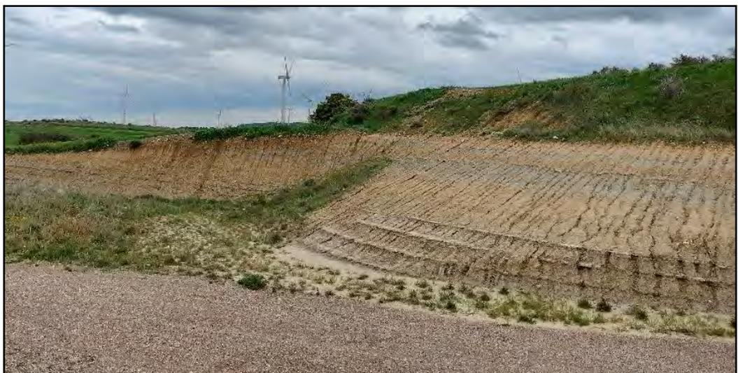
**Fotografía 7.** Desmonte con procesos erosivos al suroeste de la turbina LP03
