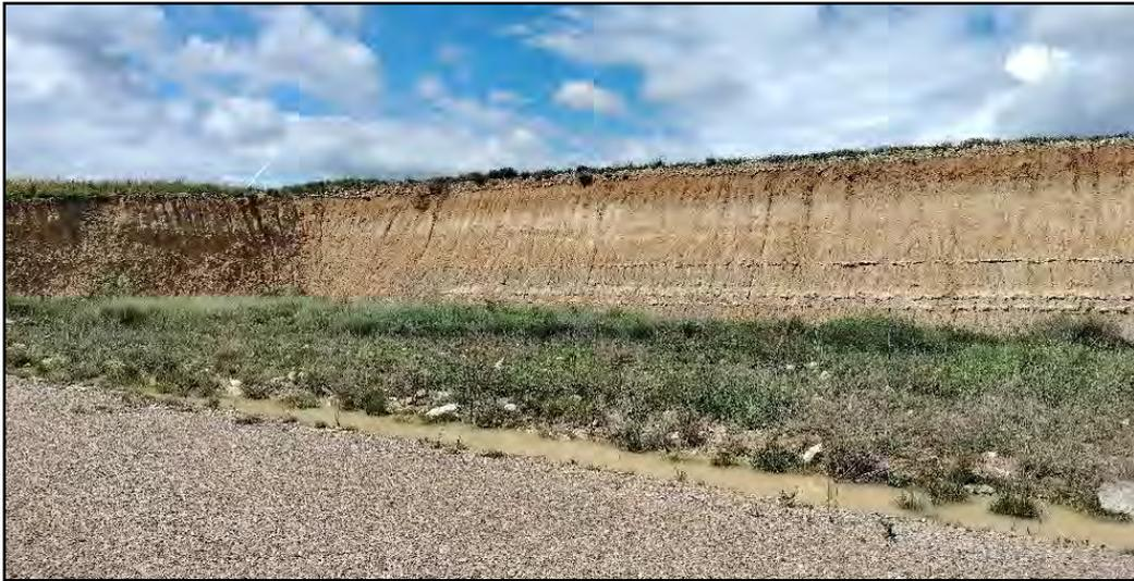
**Fotografía 10.** Desmonte al Noreste de la turbina LP08 con hidrosiembra exitosa en su base
