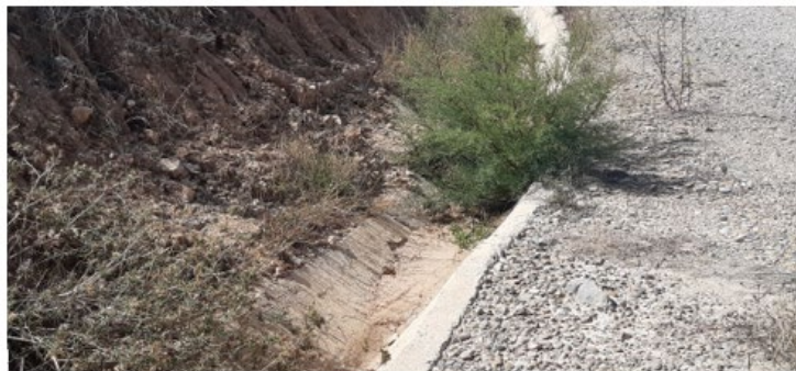
Cuneta llena de sedimentos y vegetación arbustiva en vial de acceso al aero LSA.08
