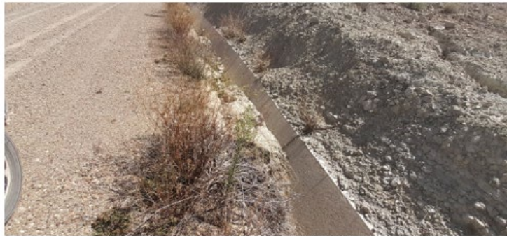
Cuneta llena de sedimentos en vial de acceso al aero LSA.04. Ambos lados del vial.
