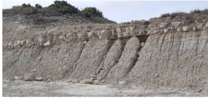
Erosión hídrica en materiales margosos del talud de desmonte del vial de acceso al aero LSA.10.
