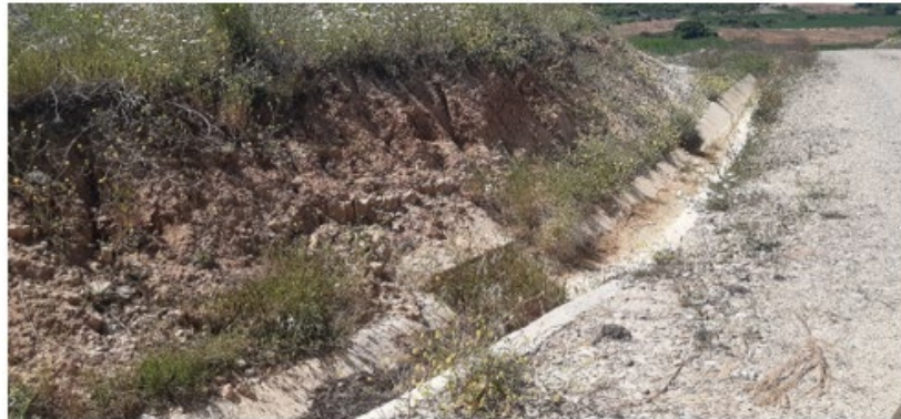
Cuneta llena de sedimentos en vial de acceso al aéro LSA.01.
