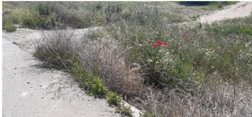
Cuneta llena de sedimentos y vegetación arbustiva en vial de acceso al aéro LSA.08
