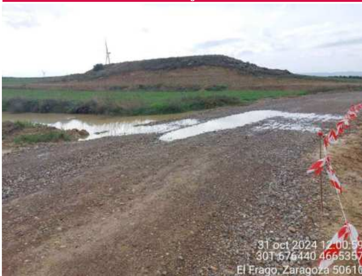
Imagen 1. Barranco cegado en vial que lleva a TM antes de ejecutar la obra que permita el paso del agua.
