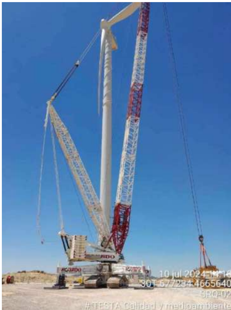
Imagen 1. Levantamiento de palas en la posición SRQ-02
