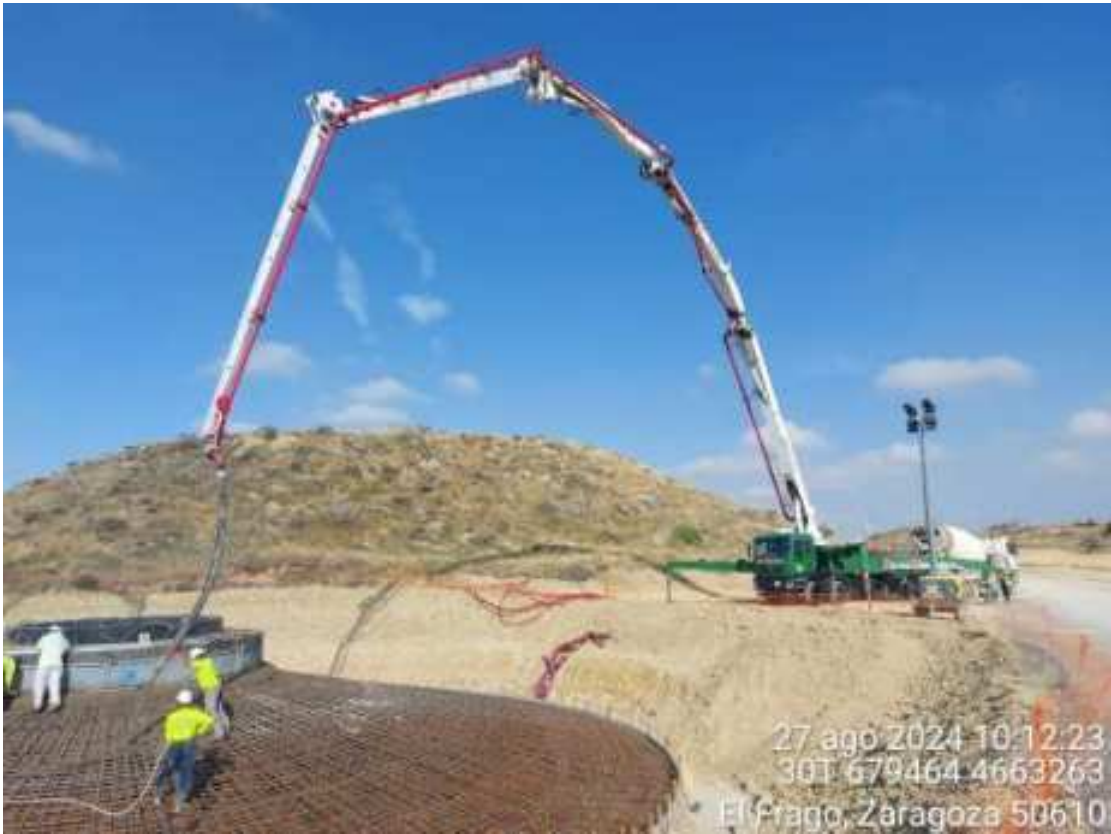
Imagen 1. Bomba trabajando en el hormigonado de PAU-08.
