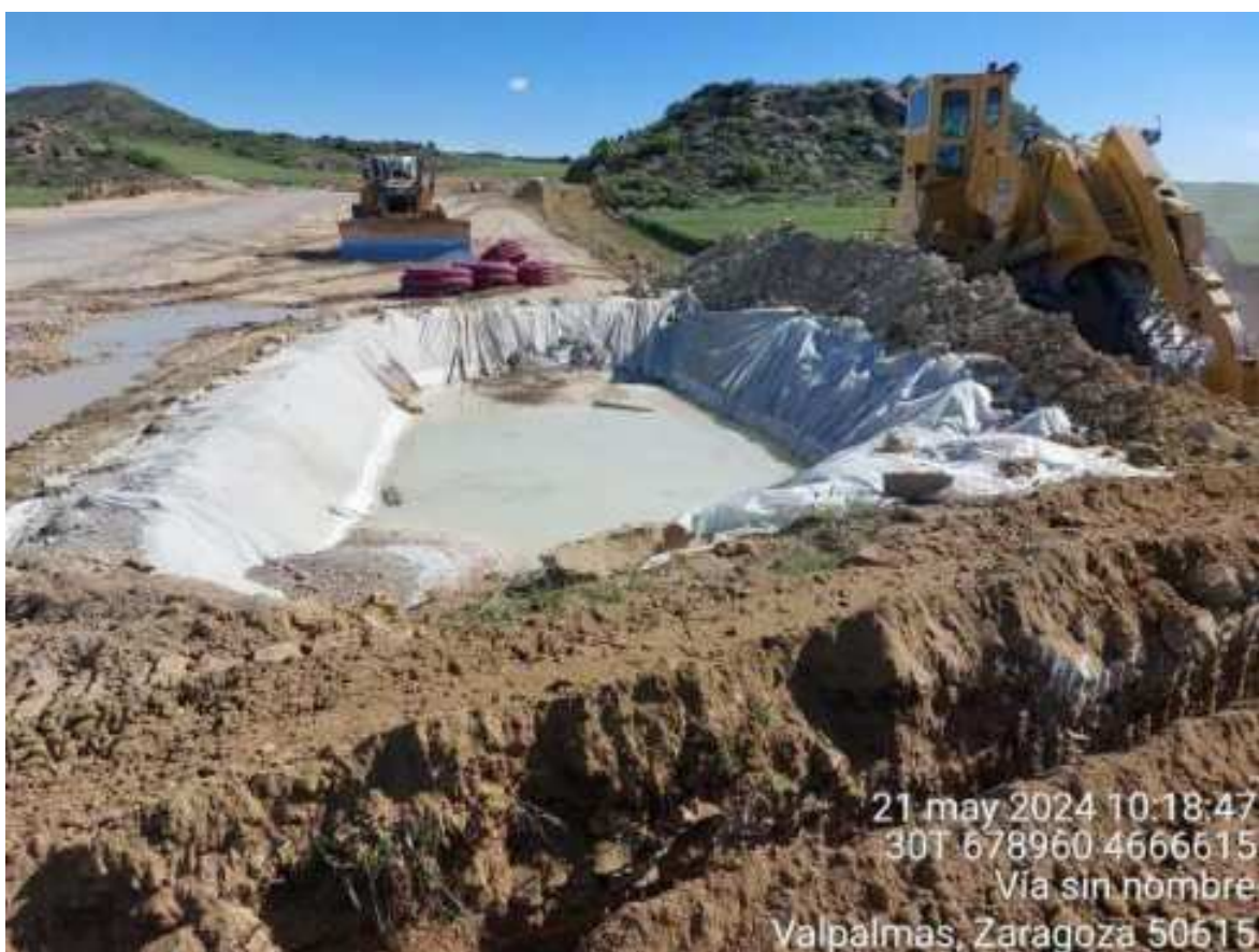
Imagen 2. NC leve. Apertura de zanja sobre residuo de hormigón.
