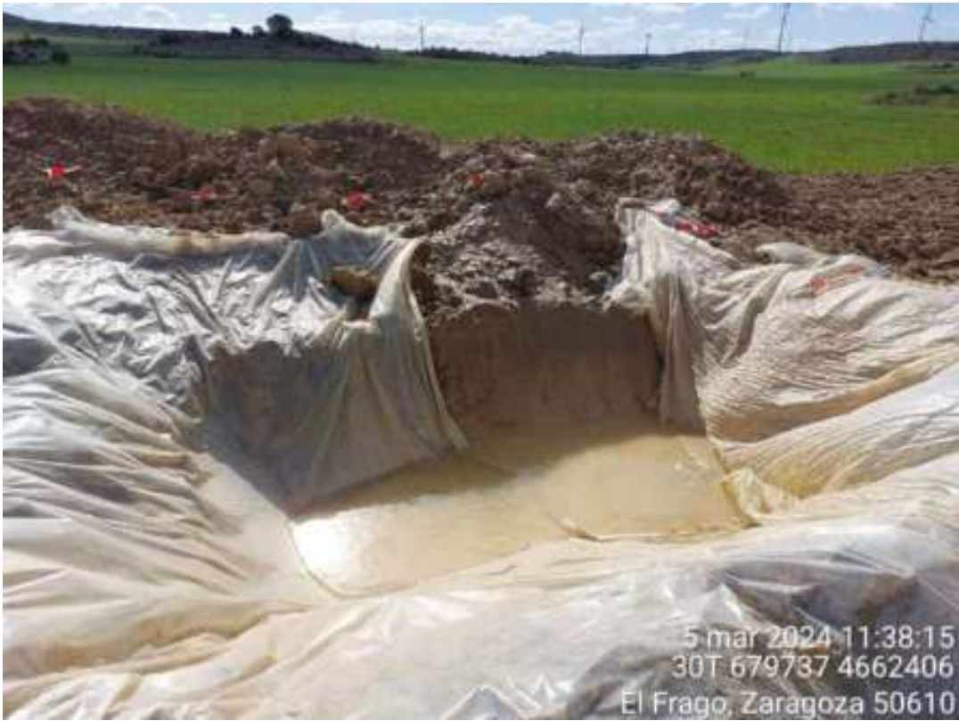
Imagen 1. Pozo de lavado que se debe reponer el plástico y vaciar debido a agua de lluvia.
