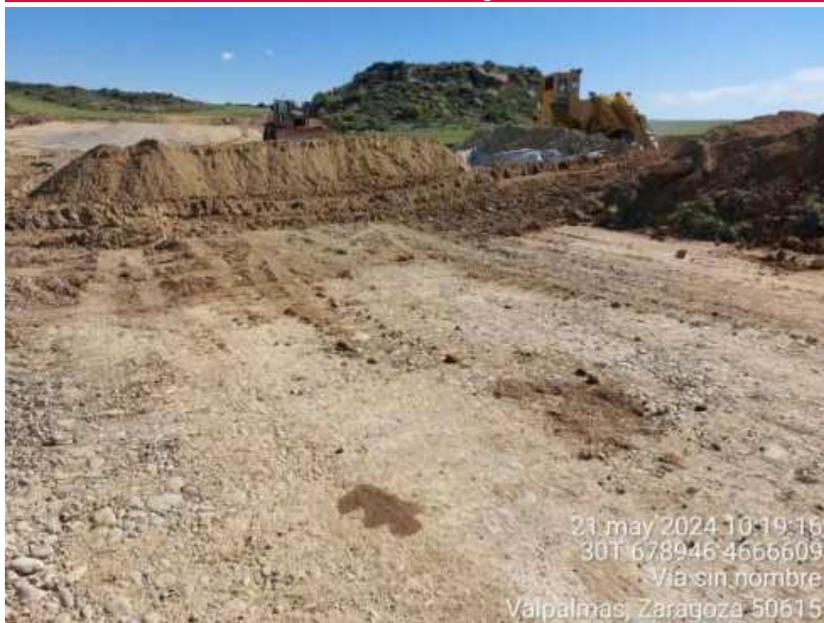
Imagen 3. NC leve. Apertura de zanja sobre residuo de hormigón.
