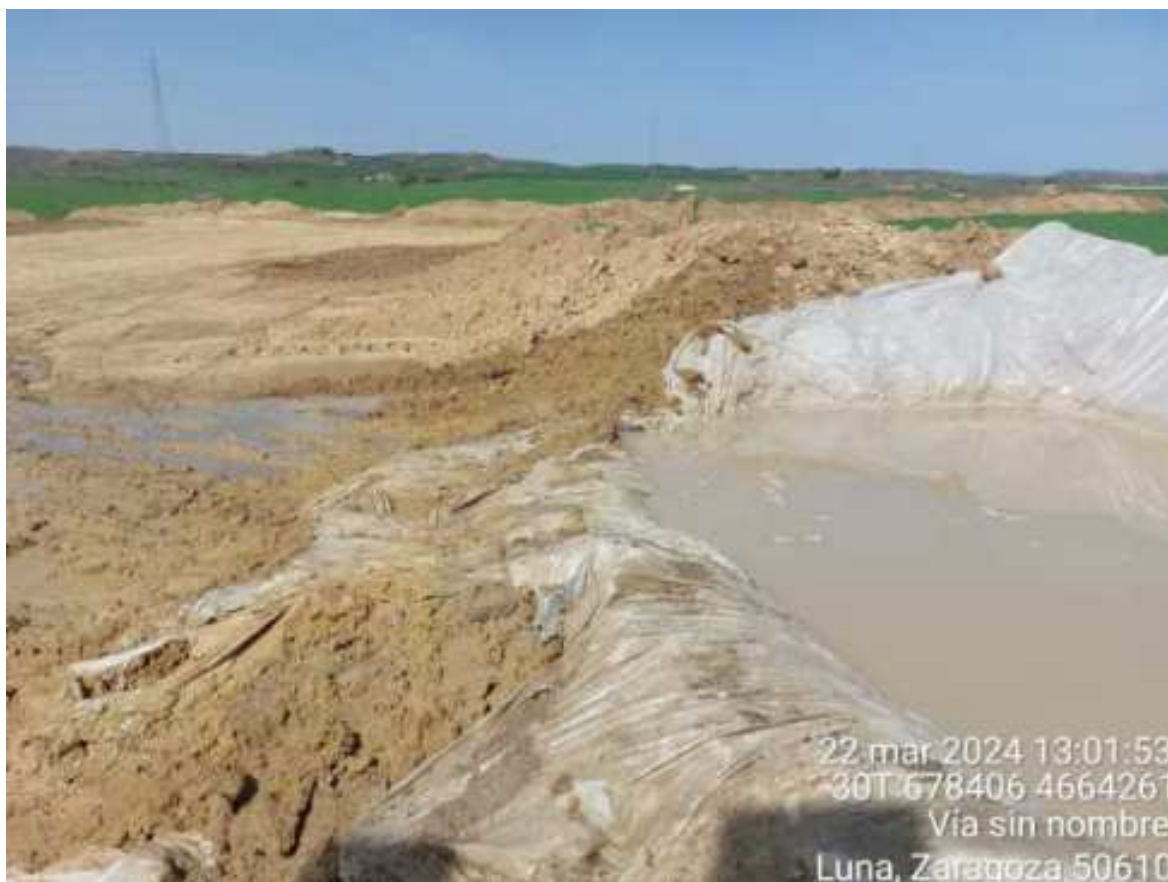
Imagen 1. No conformidad grave por desviación repetitiva en los pozos de lavado.
