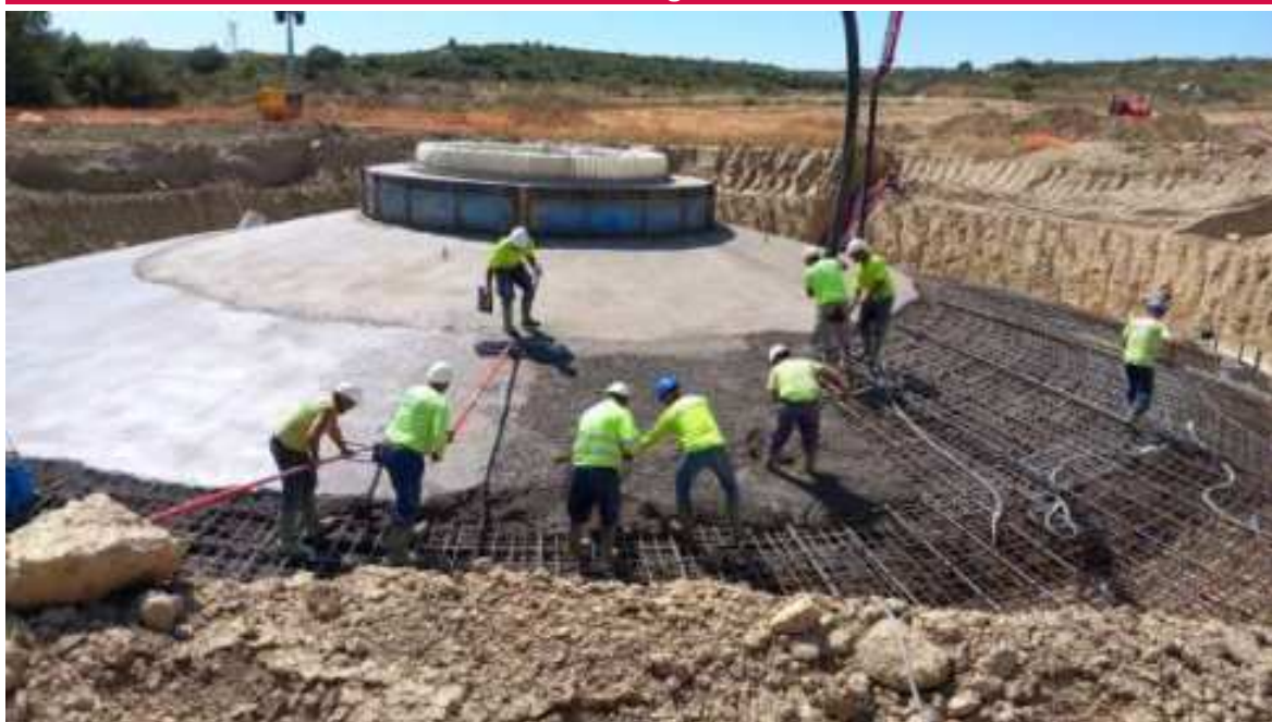
Imagen 1. Hormigonado de la posición PAU-02.
