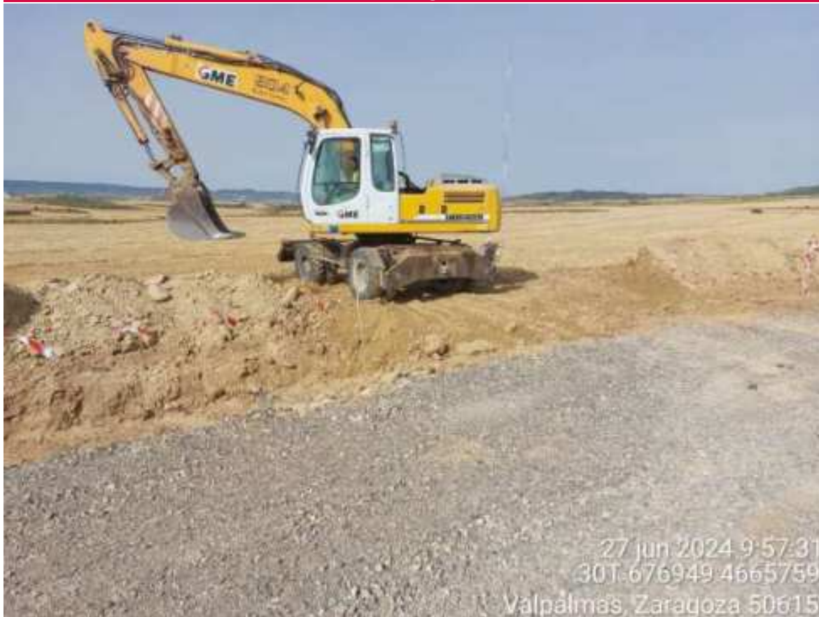
Imagen 1. Trabajos de tapado de zanja para permitir paso de agricultores para cosechar.
