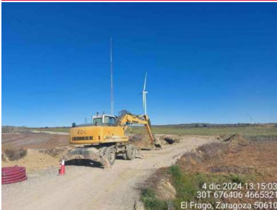
Imagen 1. Maquinaria trabajando en la odt para permitir paso del agua en el barranco entre SRQ y la TM.
