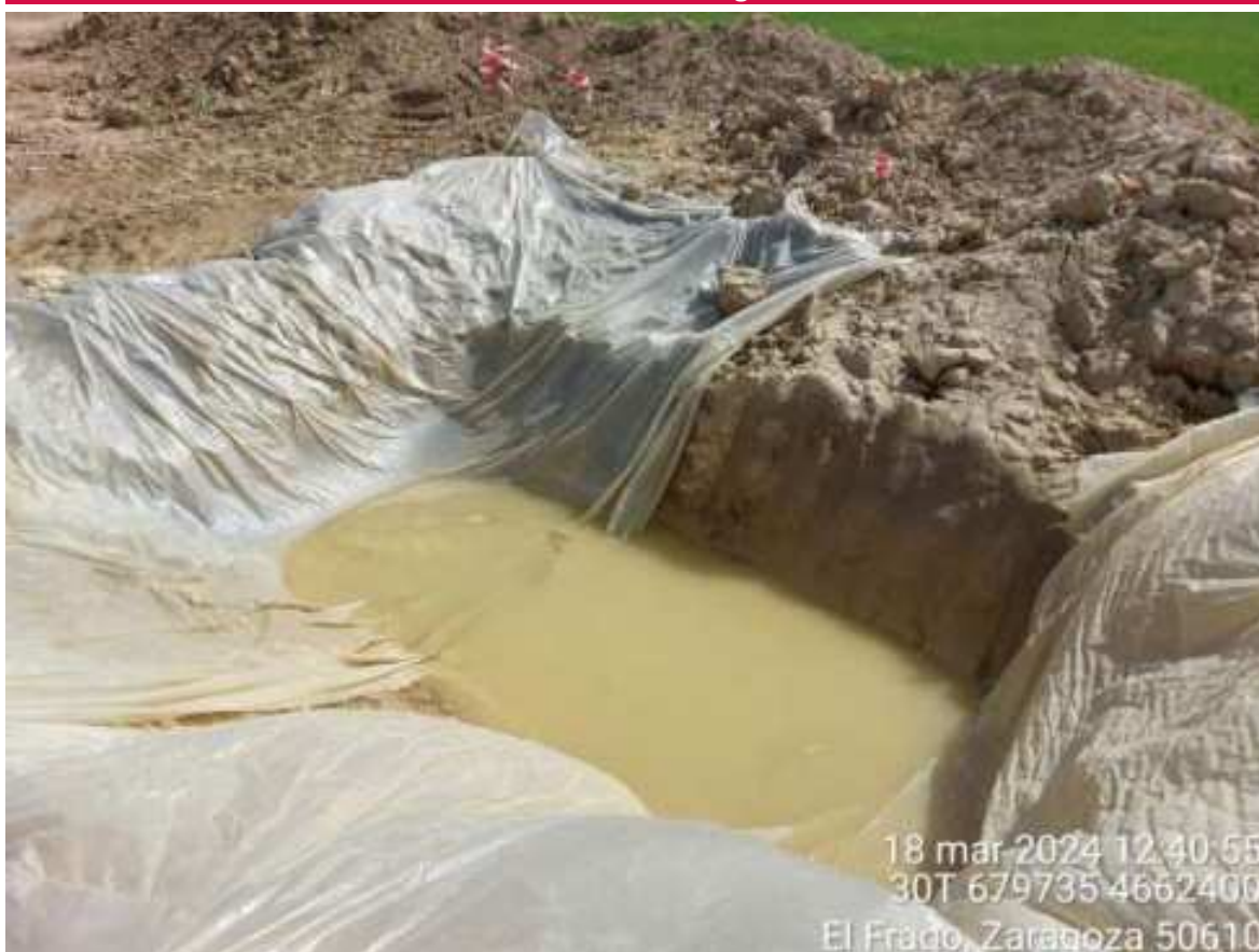
Imagen 1. Pozo de lavado con agua de lluvia en PAU-09 que debe volver a impermeabilizarse para poder ser utilizado.
