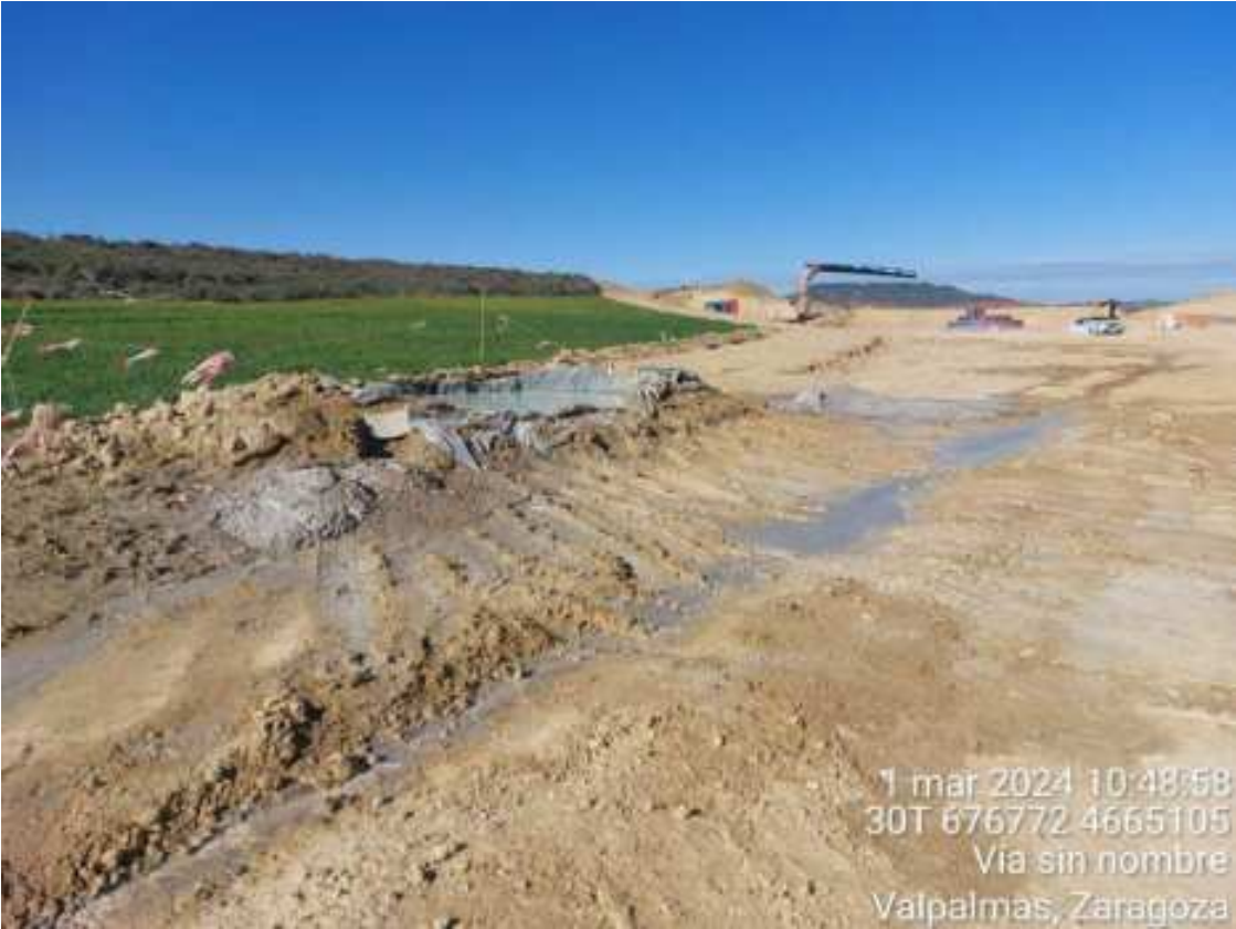
Imagen 1. No conformidad leve. Contaminación del suelo por pozo de lavado rebosado y por mal lavado de las cubas.
