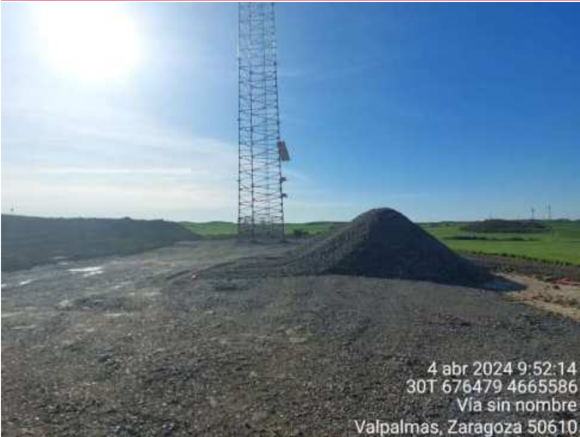
Imagen 1. TM restaurada con zahorra acopiada para extendido.
