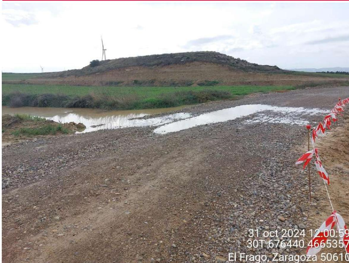
Imagen 1. Barranco cegado en vial que lleva a TM antes de ejecutar la obra que permita el paso del agua.
