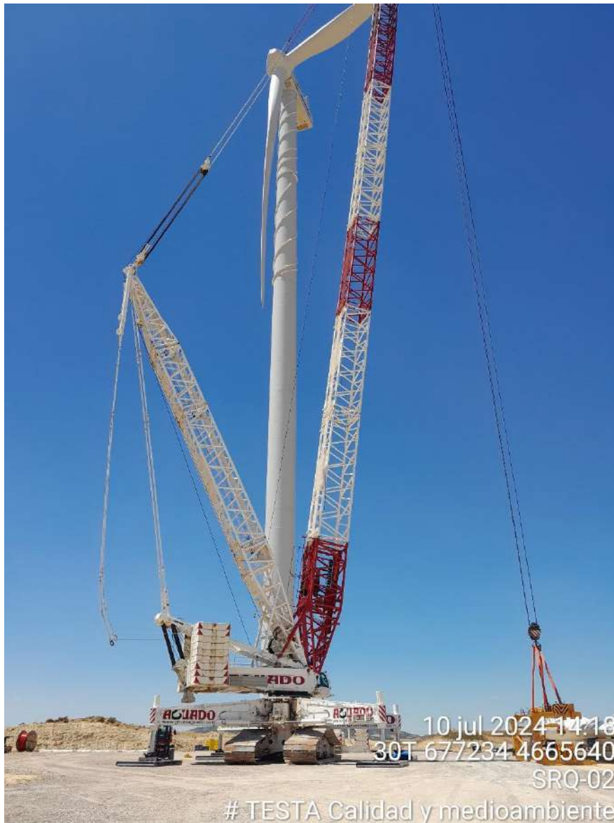
Imagen 1. Levantamiento de palas en la posición SRQ-02
