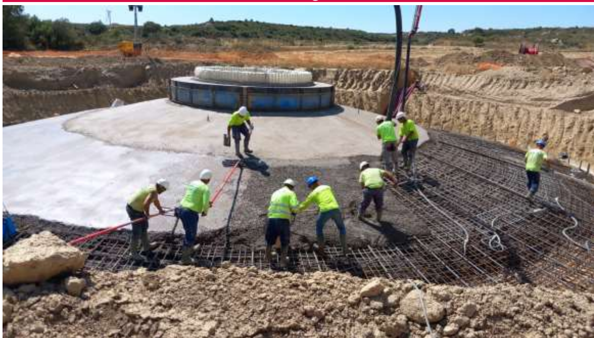
Imagen 1. Hormigonado de la posición PAU-02.
