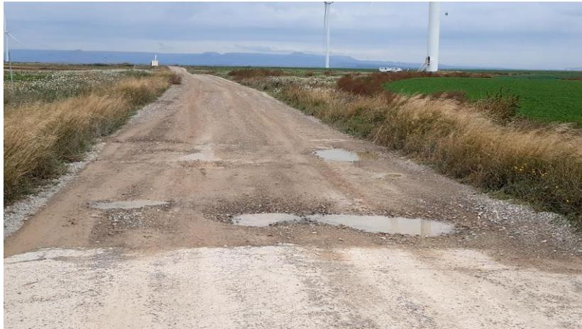
*Fig. 1 Erosión del vial de acceso a LMU.02*
