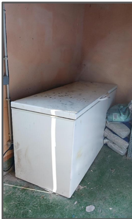
Fotografía 1. Arcón congelador del parque eólico
