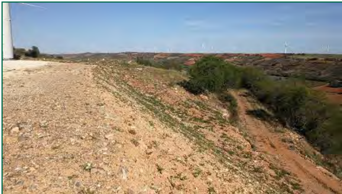
Fotografía 13. Talud en clúster Aguasvivas.
