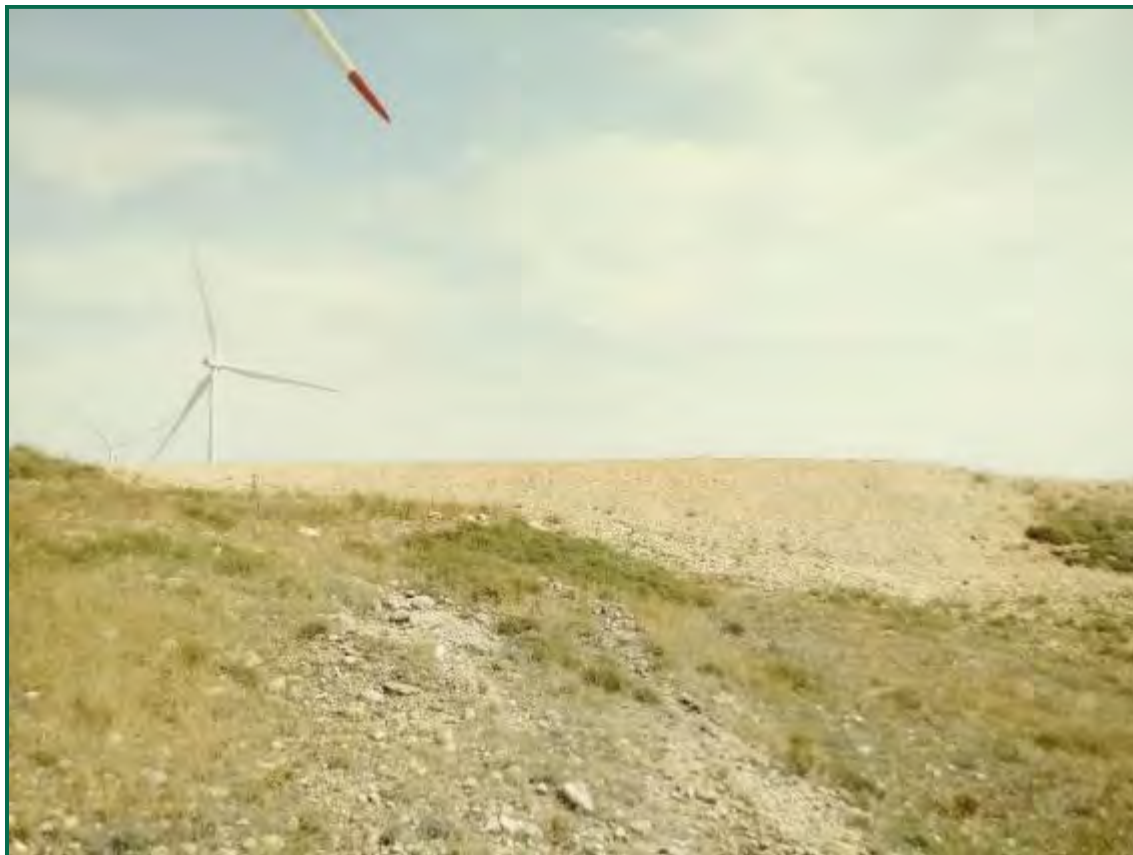
Fotografía 9. Talud en clúster Aguasvivas.
