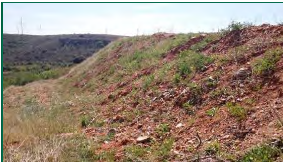
Fotografía 11. Talud en el clúster Aguasvivas.
