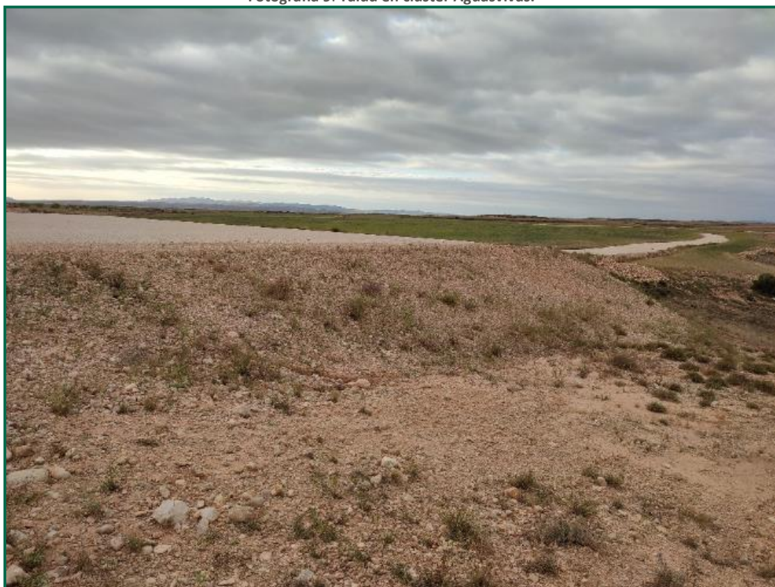
Fotografía 10. Talud en clúster Aguasvivas, aspecto actual.
