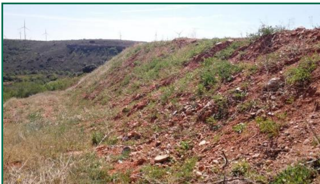
Fotografía 11. Talud en el clúster Aguasvivas.
