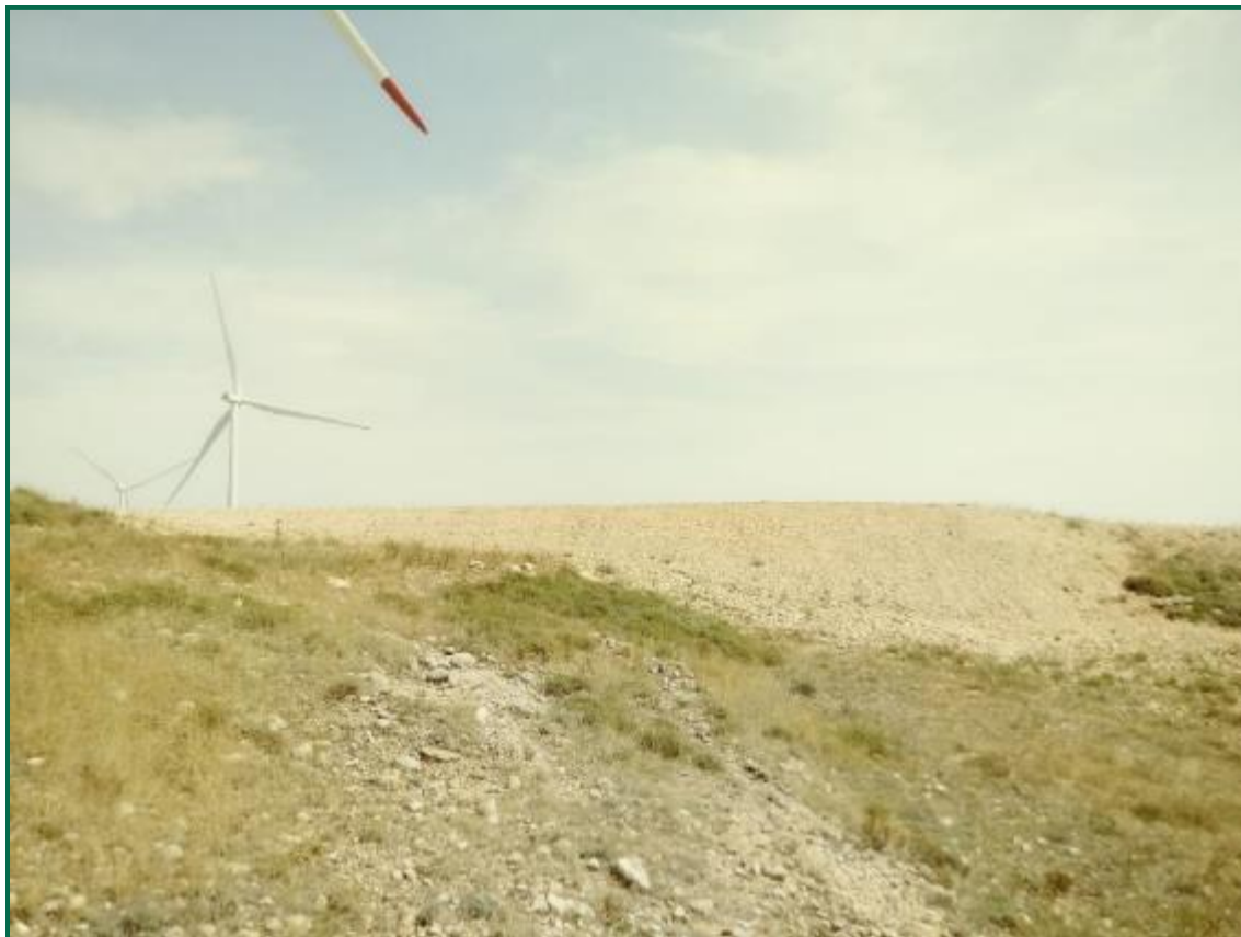
Fotografía 9. Talud en clúster Aguasvivas.
