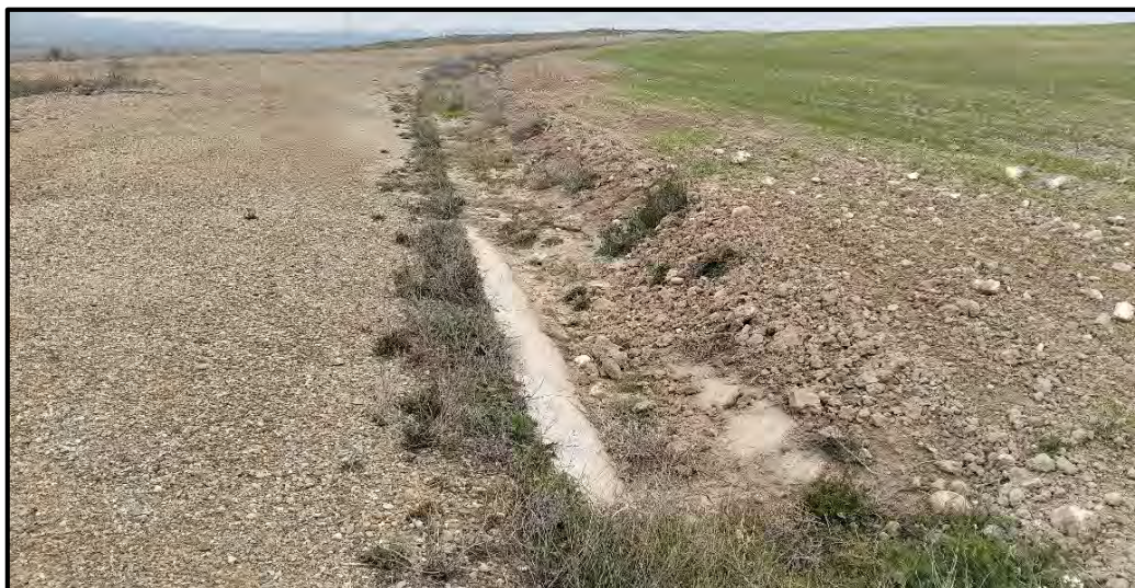
Fotografía 4. Cuneta colmatada por sedimentos finos y paso de agua obstruido por restos de vegetación seca, próximo a la turbina HE03.
