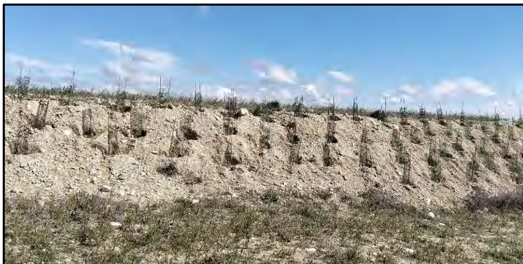
Fotografía 7. Nueva plantación con arbustos autóctonos en el talud de la plataforma de la turbina HE01.
