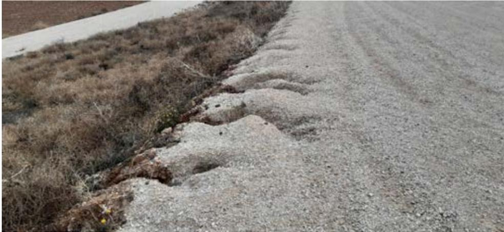
Fig. 1 Erosión hídrica en materiales detríticos del vial de acceso al aero WTG-07.
