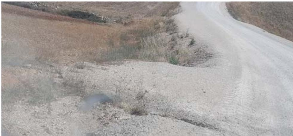
Fig. 2 Tubo de drenaje semitaponado con sedimentos en vial de acceso al aero WTG-02
