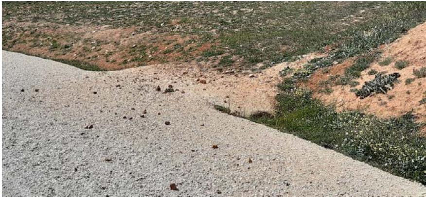
Fig. 4 Tubo de drenaje taponado por vegetación arbustiva y sedimentos en vial de acceso al aero WTG-01.
