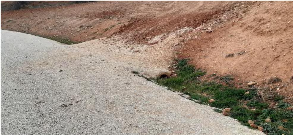
*Fig. 4 Tubo de drenaje taponado por vegetación arbustiva y sedimentos en vial de acceso al aereo WTG-01.*
