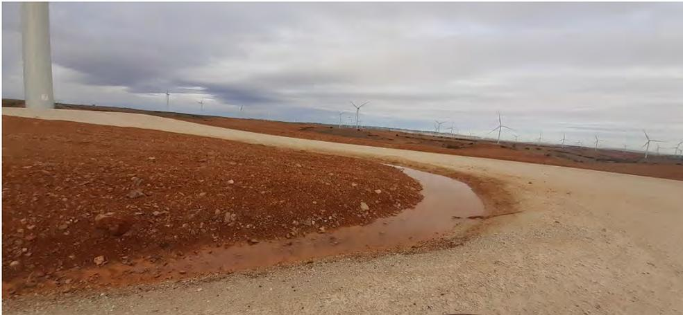
Fig. 5 Encharcamiento en margen del vial de acceso al aero WTG-05
