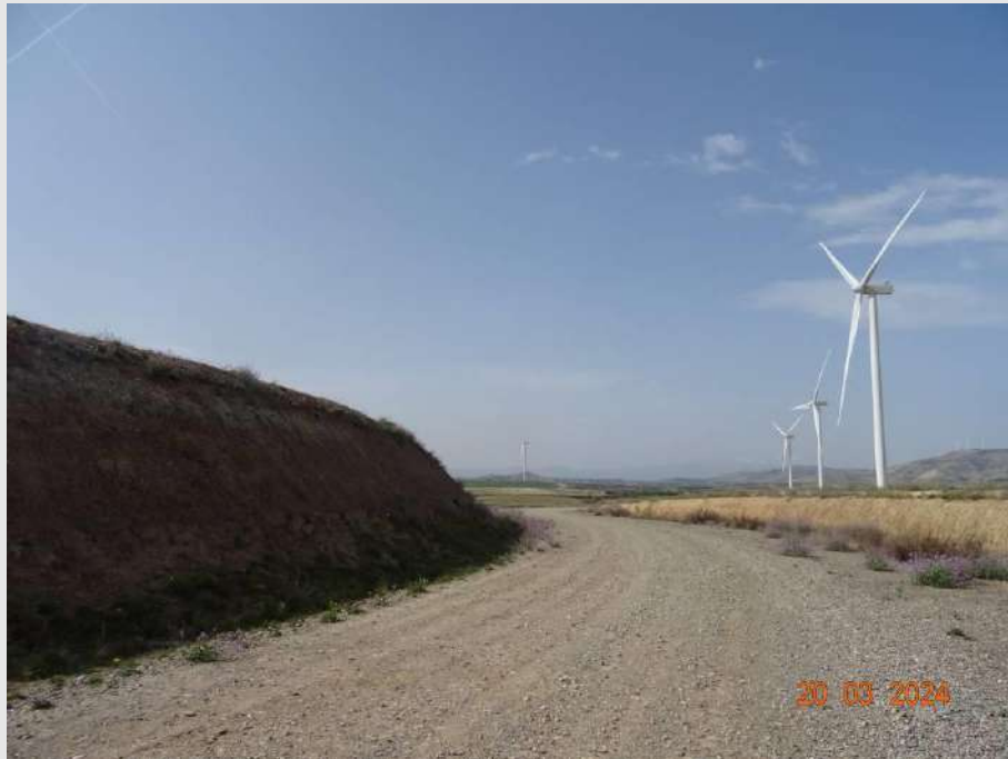
Fotografía 13. Vial de acceso a las instalaciones.
