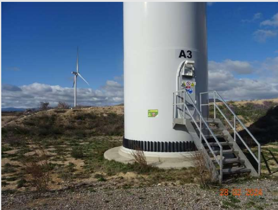
Fotografía 8. Base del aerogenerador A3.
