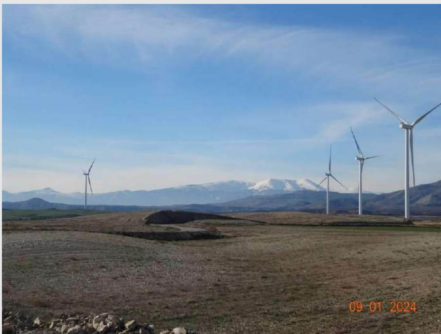
Fotografía 2. Vista general del parque eólico El Pradillo.
