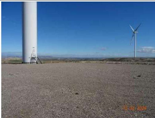
Plataforma aerogenerador A06.
