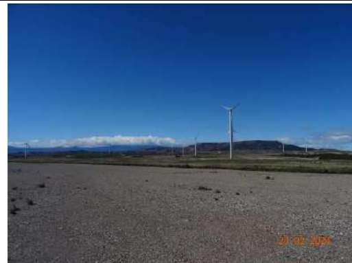
Plataforma aerogenerador A07.
