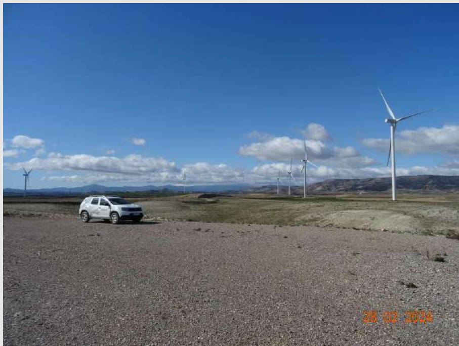
Fotografía 6. Vista general del parque eólico El Pradillo.
