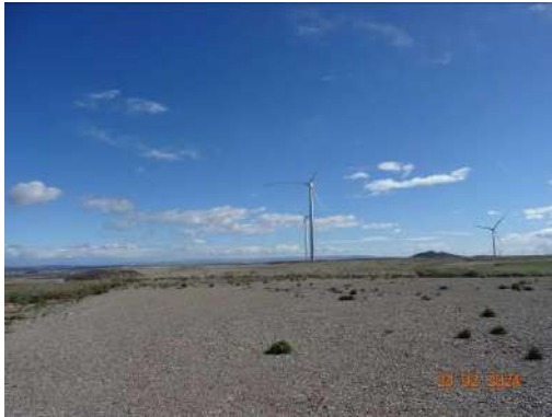
Plataforma aerogenerador A05.
