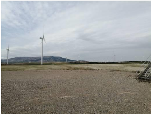
Plataforma aerogenerador A06.
