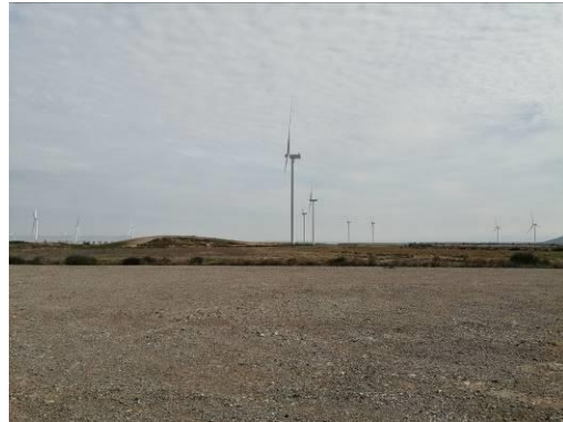
Plataforma aerogenerador A03.
