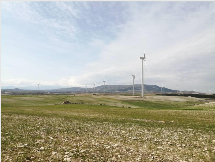
Fotografía 4. Vista general del parque eólico Pradillo.
