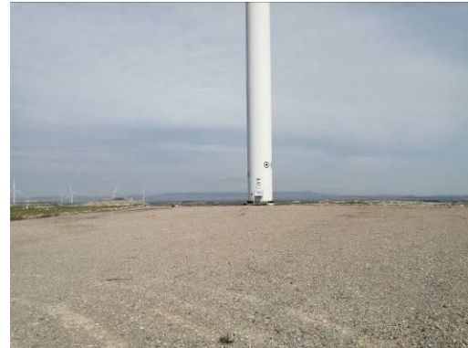
Plataforma aerogenerador A07.
