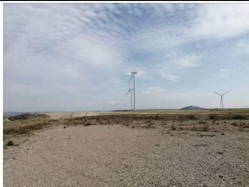
Plataforma aerogenerador A05.
