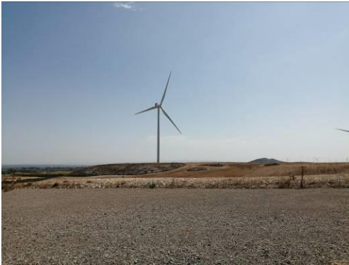
Plataforma aerogenerador A06.
