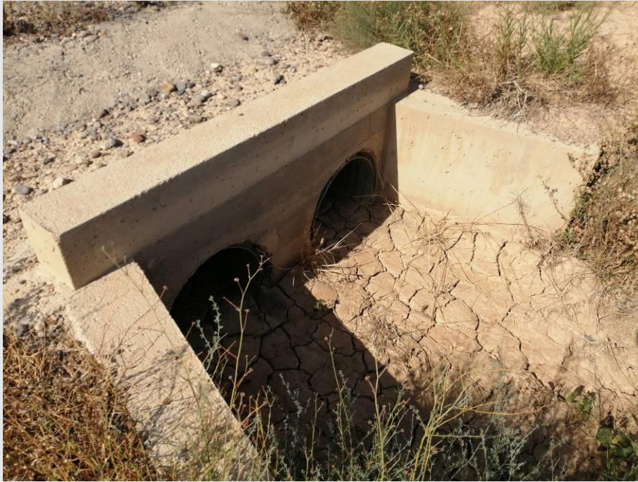
Fotografía 9. Detalle de drenaje transversal.
