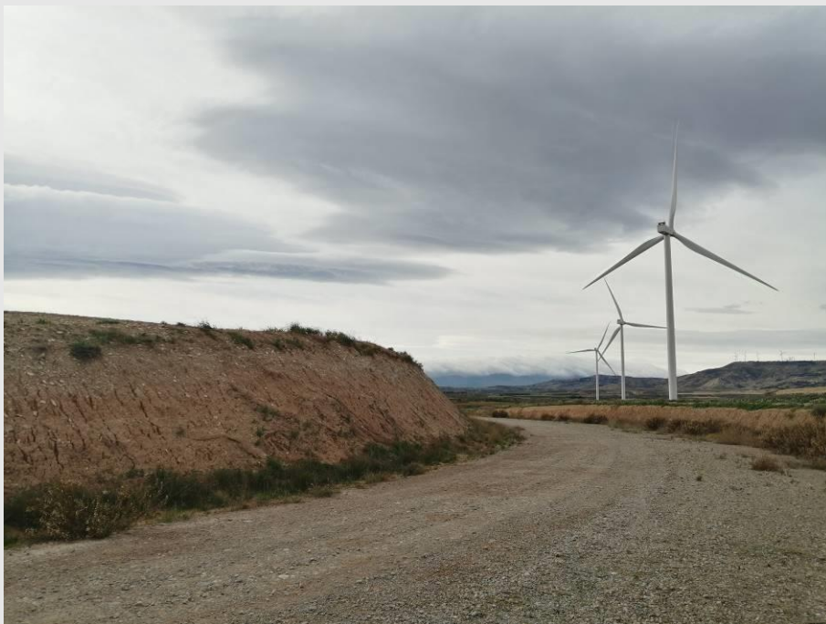
Fotografía 2. Vista general del parque eólico El Pradillo.
