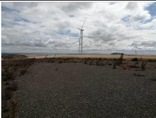
Plataforma aerogenerador A05.
