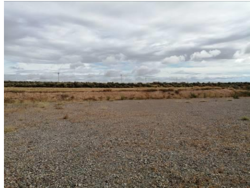
Plataforma aerogenerador A03.
