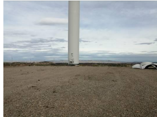
Plataforma aerogenerador A07.
