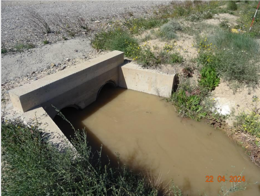
Fotografía 11. Drenaje transversal en el recinto del parque eólico El Pradillo.
