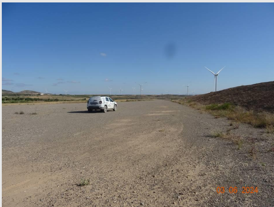
Fotografía 6. Vista general del parque eólico El Pradillo.
