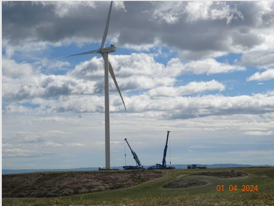
Fotografía 13. Maquinaria trabajando en un aerogenerador.
