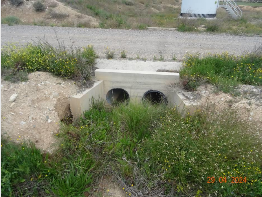
Fotografía 9. Drenaje transversal.
