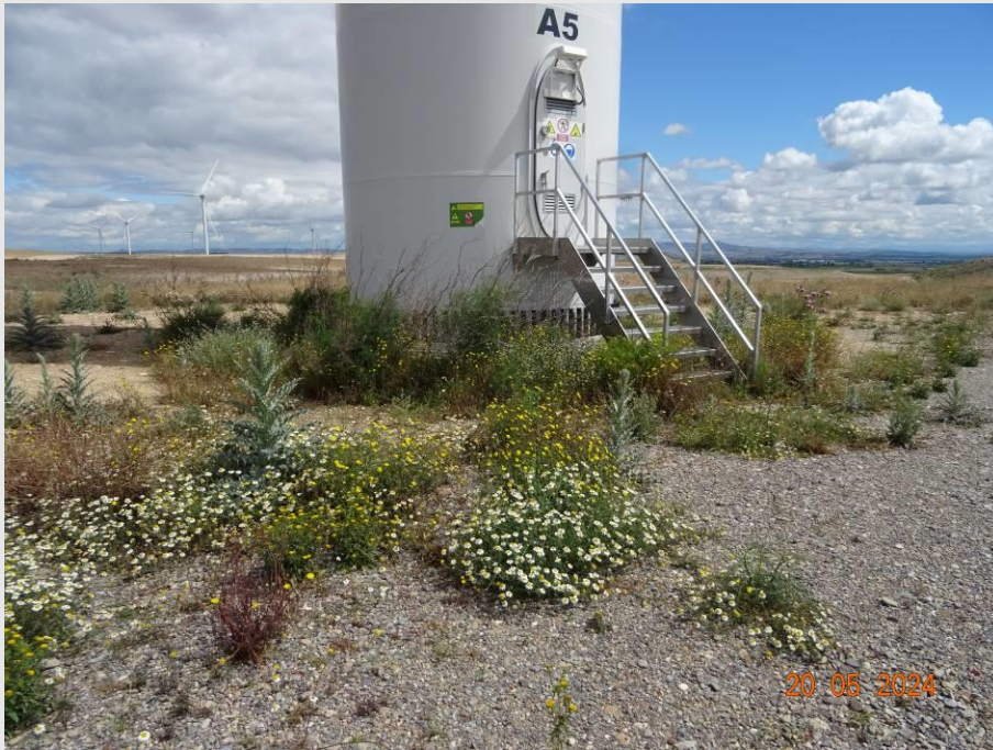
Fotografía 7. Base del aerogenerador A5.
