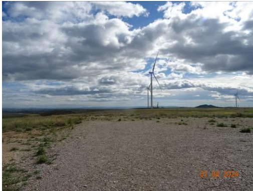
Plataforma aerogenerador A05.
