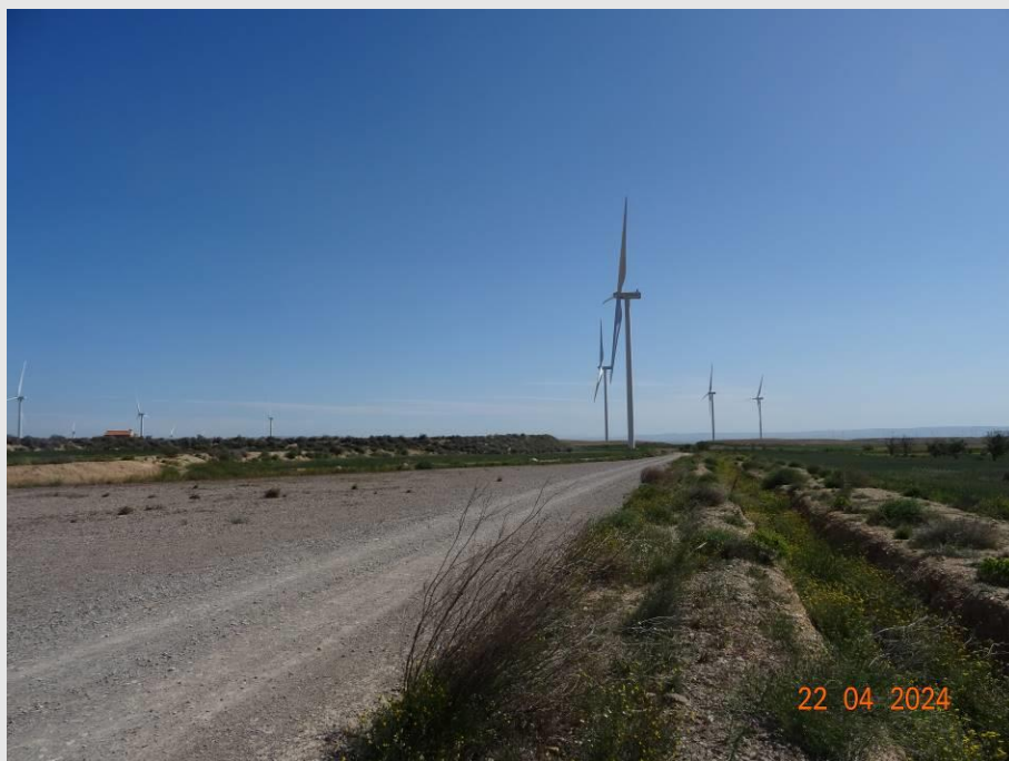
Fotografía 2. Vista general del parque eólico El Pradillo.
