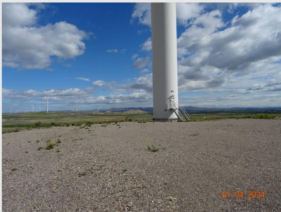
Fotografía 14. Plataforma del A6 del parque eólico El Pradillo.
