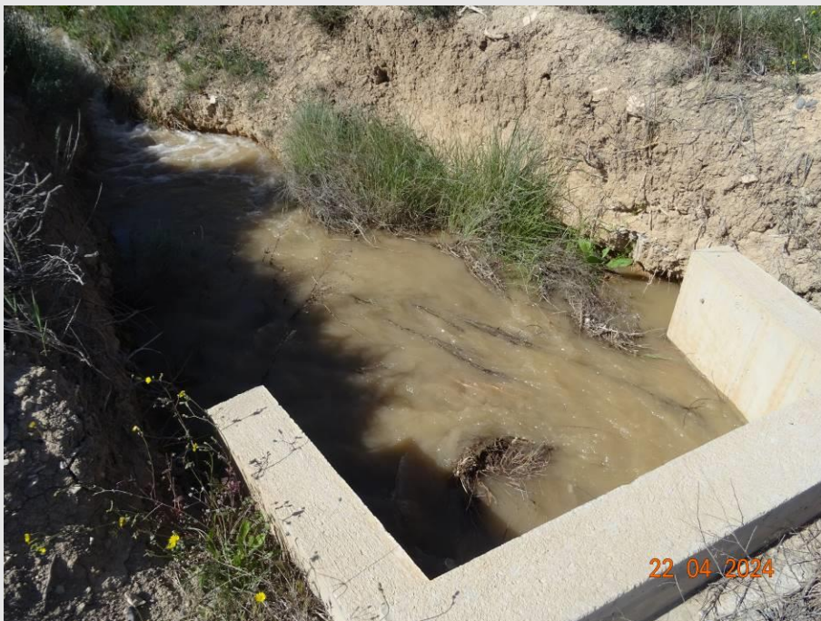
Fotografía 12. Detalle de una arqueta de drenaje del parque eólico El Pradillo.
