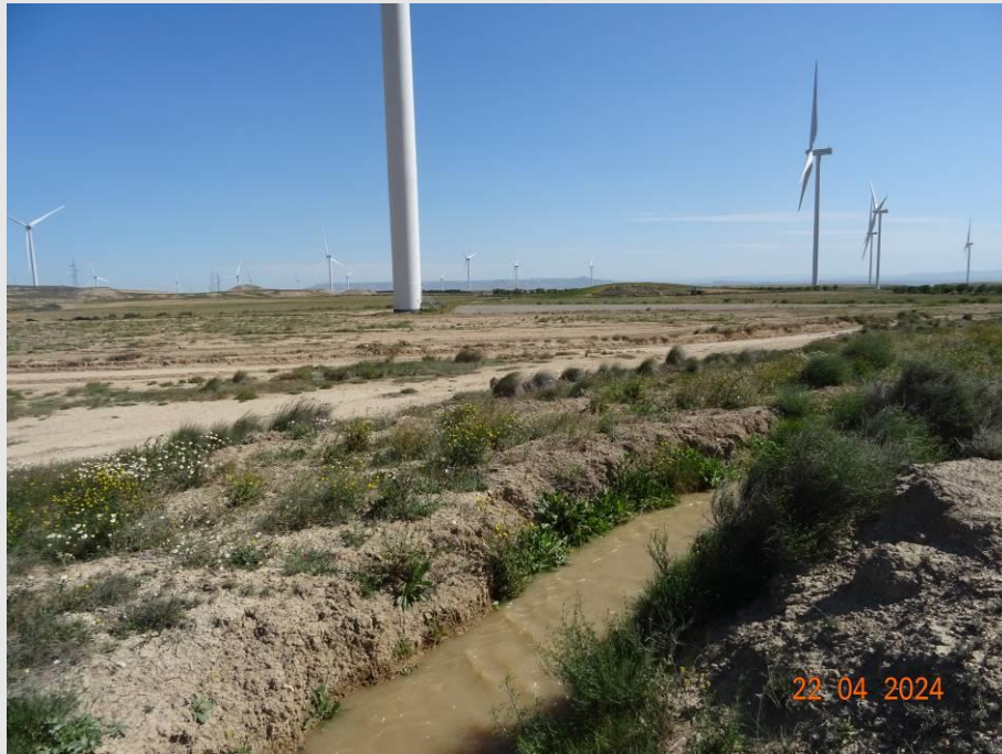
Fotografía 1. Detalle de un arroyo entorno de las instalaciones.
