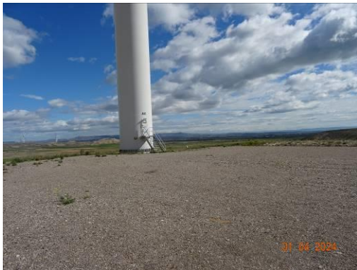
Plataforma aerogenerador A06.
