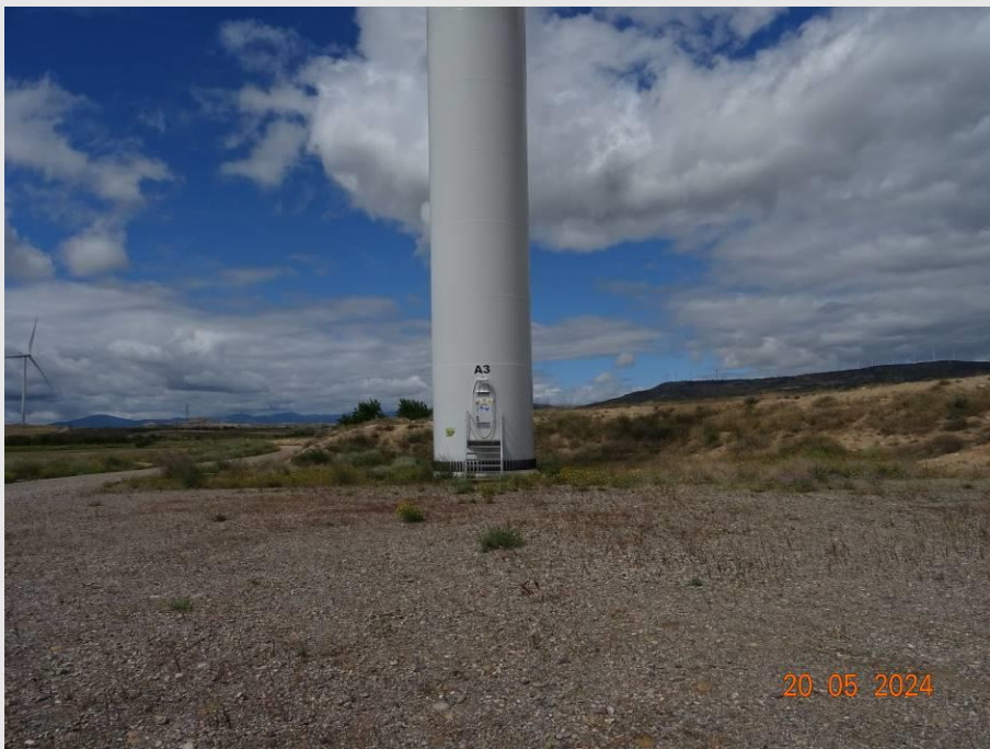
Fotografía 8. Base del aerogenerador A3.
