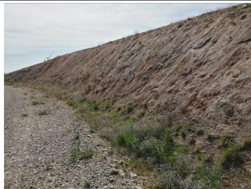
Talud en el camino entre aerogeneradores A05 y el A06
