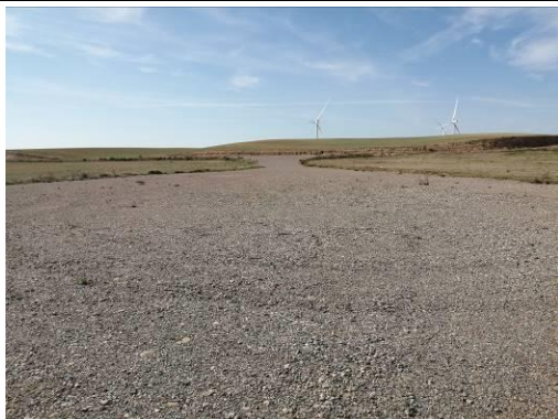
Plataforma aerogenerador A05.
