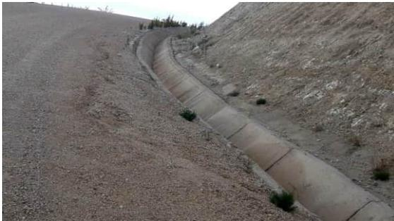
Fig. 2 Erosión en el vial de acceso al aerogenerador COT-03
