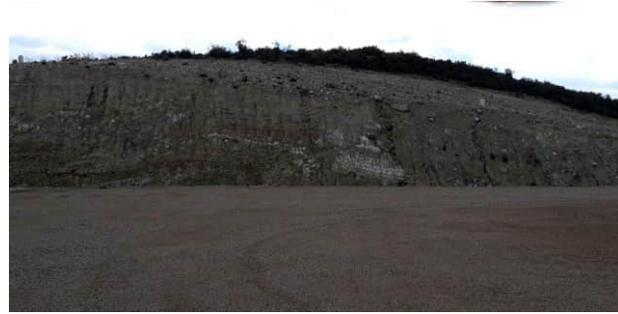
Fig. 3 Erosión en el talud de desmonte de la plataforma del aerogenerador COT-04
