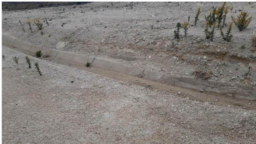
Fig. 1 Cuneta llena de sedimentos en el vial de acceso al aerogenerador COT-05
