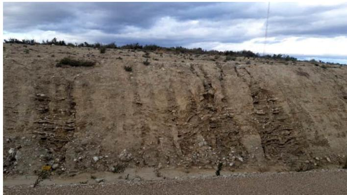
Fig. 4 Erosión en el talud de desmonte del vial de acceso al aerogenerador COT-05
