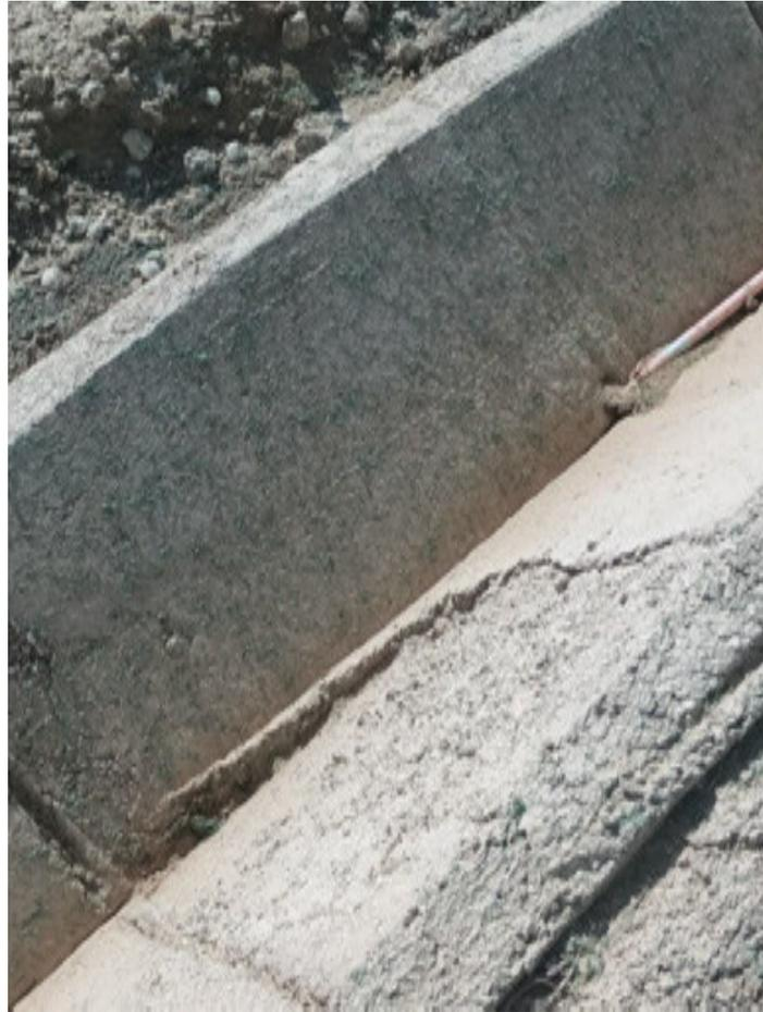
*Figura 3: Ejemplo de cuneta mal terminada en el vial de acceso*
