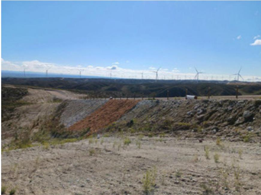
*Figura 1: Extendido de malla de coco en vial de acceso*
