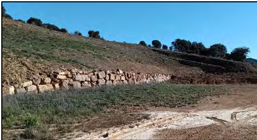
Fotografía 5. Acondicionamiento del talud junto a la turbina CAS02 (01/04/2025).
