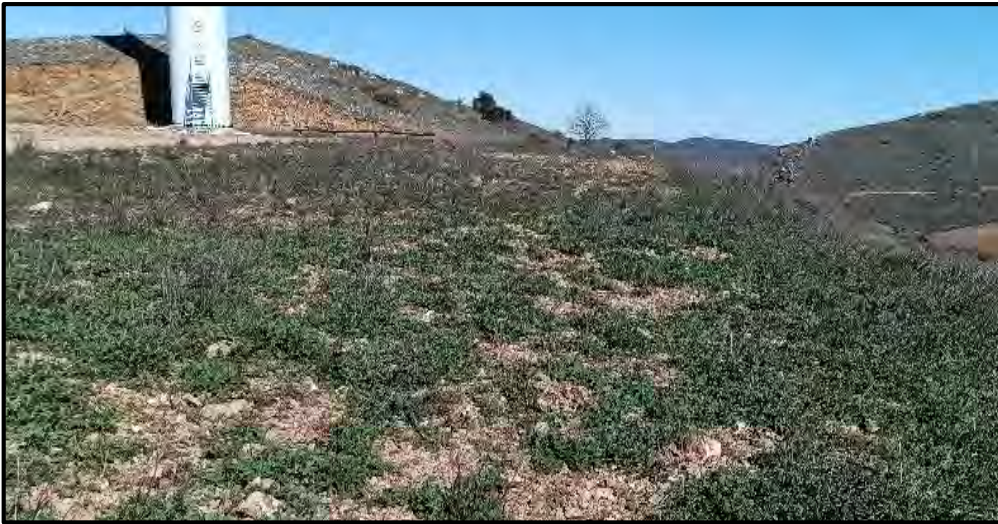
Fotografía 8. Colonización espontánea de la flora silvestre en la plataforma en la turbina CAS03 (01/04/2025).
