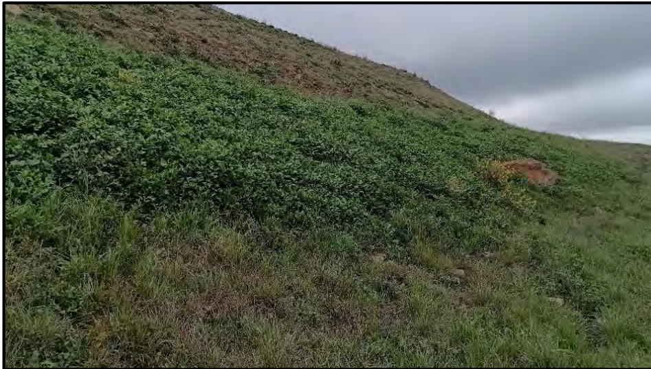
Fotografía 13. Estado actual del talud de la plataforma de la turbina CAS04.
