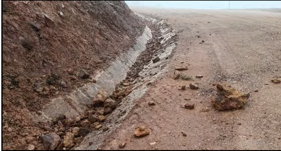
Fotografía 7. Proceso erosivo de pequeña magnitud a lo largo del parque eólico.
