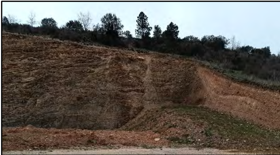
Fotografía 11. Estado actual del talud de la plataforma de la turbina CAS05
