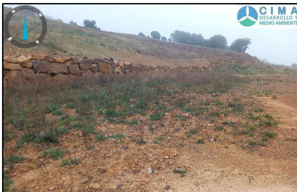
Fotografía 8. Evolución positiva de la revegetación mediante hidrosiembra en la plataforma de la turbina CAS02 y la colonización paulatina del talud por parte de especies silvestres.
