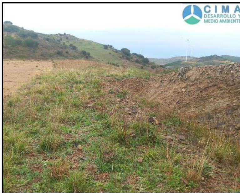
Fotografía 13. Evolución positiva de la revegetación mediante hidrosiembra en la plataforma de la turbina CAS07
