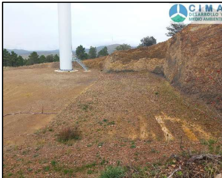
Fotografía 11. Menor cobertura herbácea en la plataforma de la turbina CAS05 debido al pastoreo.
