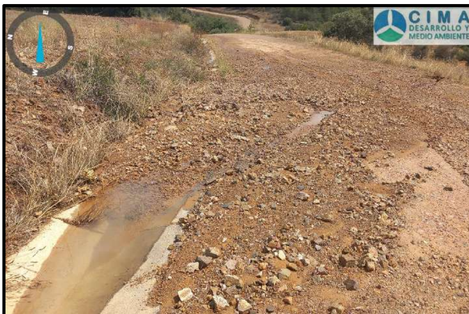
Fotografía 2. Cuneta colmatada por arrastre de sedimento durante un evento intenso de lluvia en el sector occidental
