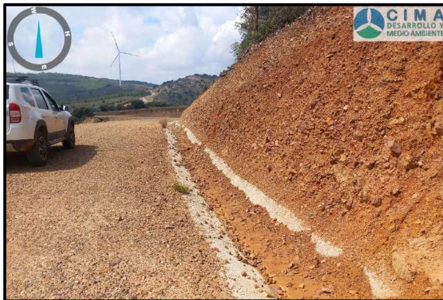
Fotografía 3. Colmatación parcial de un paso de agua en el vial principal por pequeños colapsos de la pendiente o desprendimiento de material fino.
