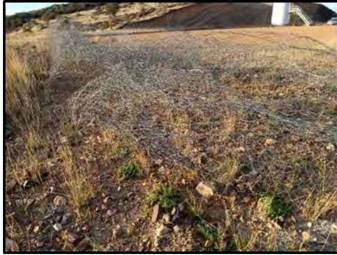
Fotografía 13. Malla de contención en la plataforma de la turbina CAS01
