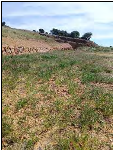
Fotografía 9. Estado de la hidrosiembra en la plataforma del aerogenerador CAS02 (zona de densidad media)
