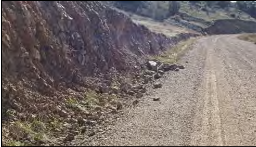
Fotografía 2. Derrumbe de rocas en el vial principal a la altura de la antena meteorológica
