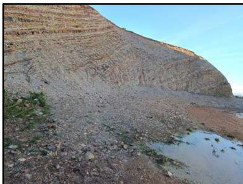
Fotografía 3 Retirada de la malla de contención y estabilización de la pendiente del desmonte en CAS01
