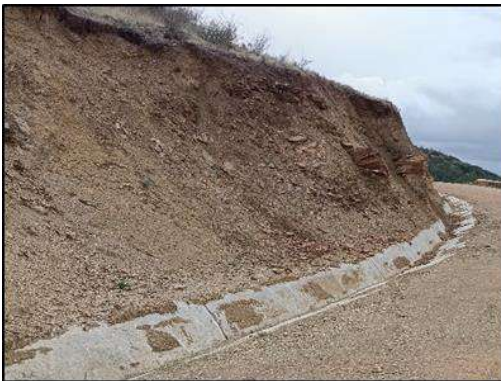
Fotografía 2. Ejemplo de cuneta limpia (izquierda) y estabilización del talud de la plataforma del aerogenerador CAS04 (derecha)
