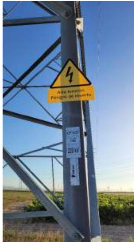
Fotografía 21: Señalización apoyos de la línea de alta tensión
