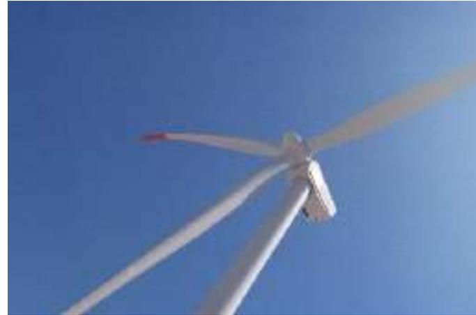
*Fotografías 5 y 6: Barquilla del aerogenerador sin derrames de aceite*
