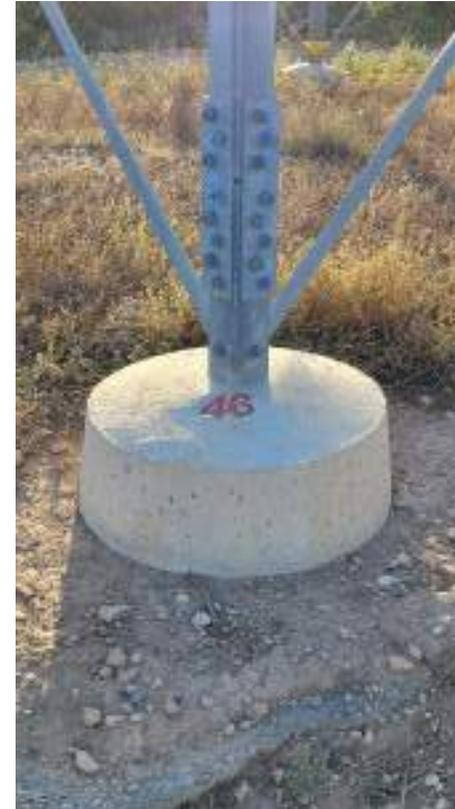
*Fotografías 22 y 23: Señalización bases apoyos de la línea de alta tensión*
