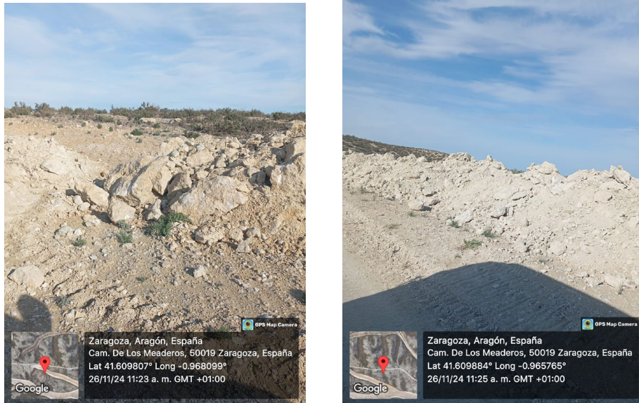
Fig 1 y 2. Excavación y acopio de materiales en el entorno de la zanja de la línea de evacuación
