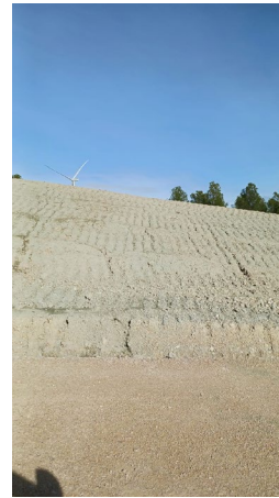
Fig 1 y 2. Taludes hidrosembrados en CAM-01.
