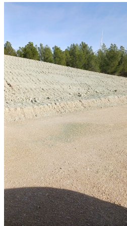
Fig 1 y 2. Taludes hidrosembrados en CAM-01.
