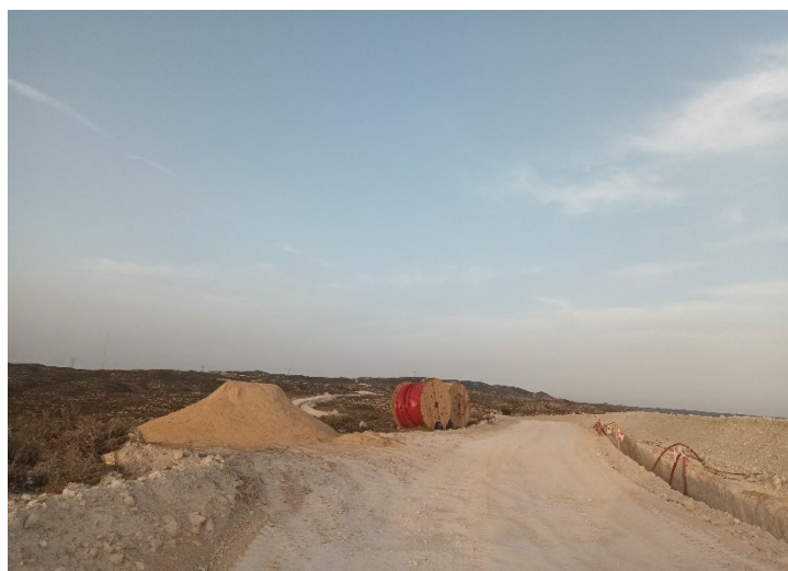
Figura 2: Bobinas y arena sobre vegetación natural
