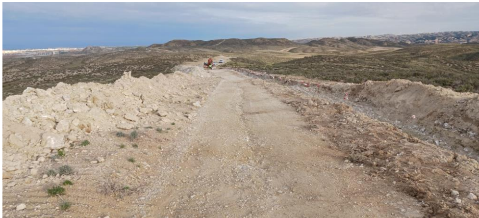
Fig. 1. Deposito de material de excavación sobre terreno revegetando
