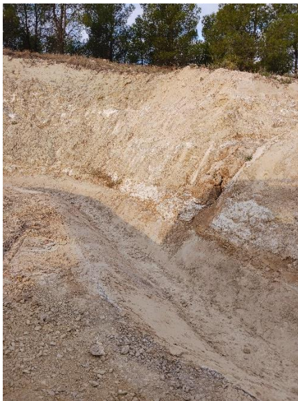
Fig 1. Limpieza cuneta CAM-15
