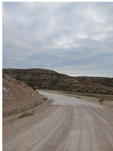
Fig 3. Limpieza vado de hormigón vial CAM-02 y CAM-12
