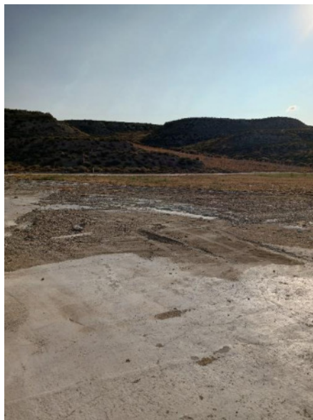
Fig 3. Sedimentación en la losa de hormigón de vaguada CAM-02 y CAM-12
