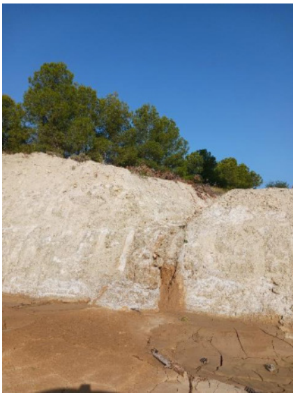
Fig 1. Colmatación de zanja en la CAM-15
