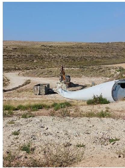
Figura 2: Trabajos de retirada de la pala
