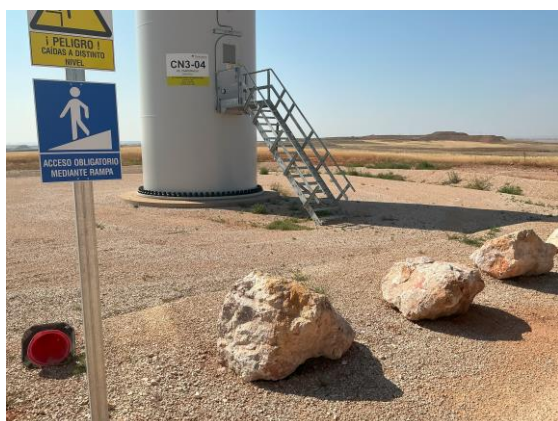
Plataforma finalizada a falta de retirada de cartelería antigua en aerogenerador CN3-04.
