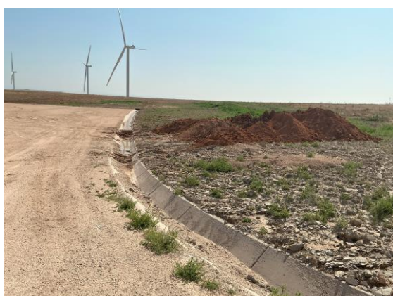
Acopio de tierra vegetal en aerogenerador CN3-05
