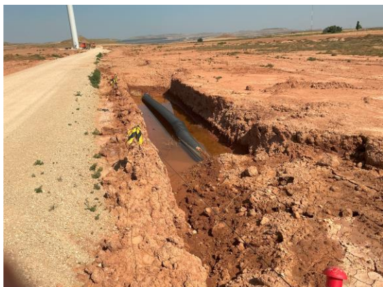
Drenaje sin finalizar y acopio de aridos en el aerogenerador CN3-07
