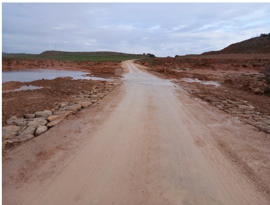
Foto 1: trabajos en el barranco de Valdecara.
