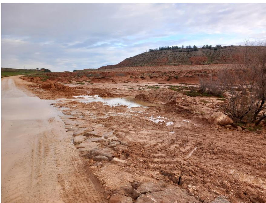
Foto 2: trabajos en el barranco de Valdecara.
