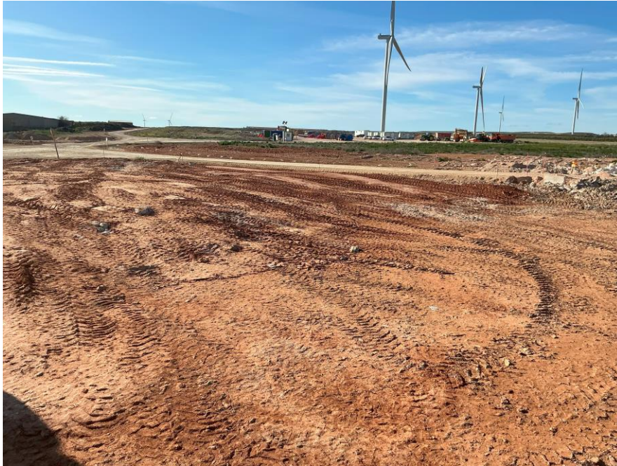
Foto 1: Compactación por maquinaria en parcela adyacente a plataforma.
