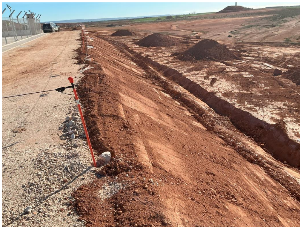
Foto 4: finalización de drenaje en CN3-01.
