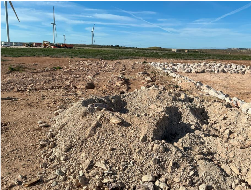
Foto 2: Zona con materiales de excavación a retirar.
