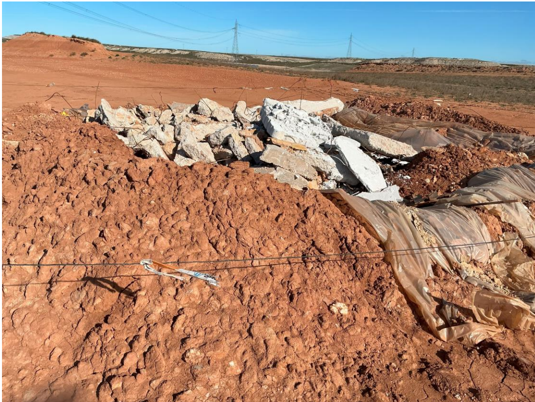
Foto 5: balsa de residuos de hormigón en estado deficiente.
