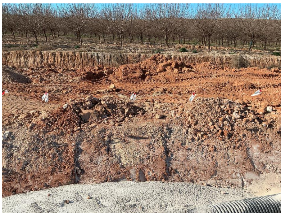
Foto 2: excavación en un lateral de la zona de drenaje.
