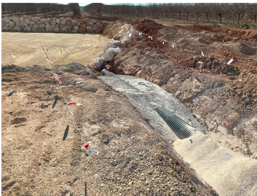
Foto 1: ejecución de drenaje en plataforma.
