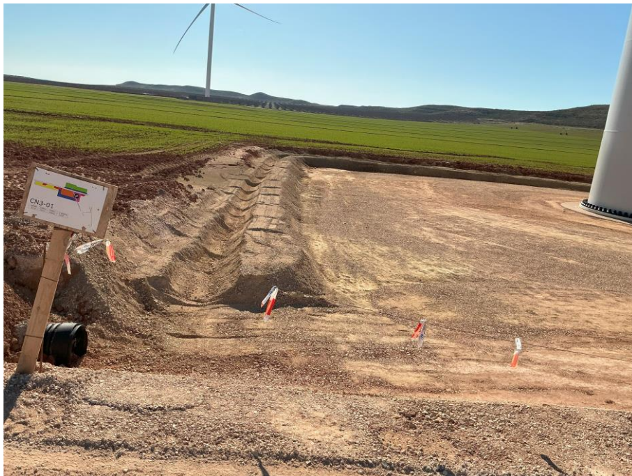
Foto 4: finalización de drenaje en CN3-01.
