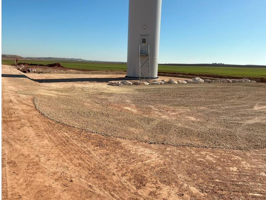
Foto 3: Plataforma finalizada a falta de drenaje.
