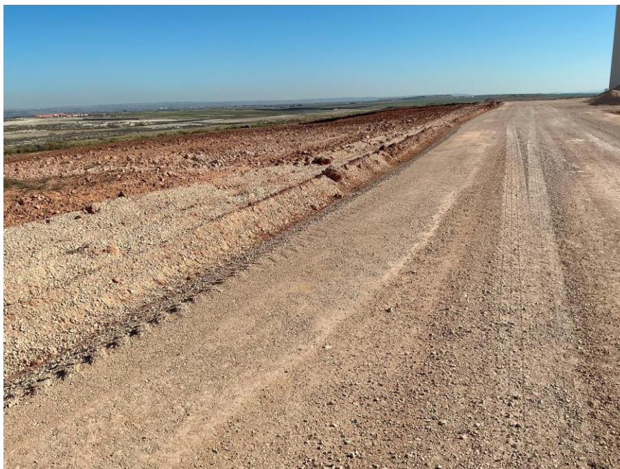
Foto 5: restos de zahorra en campo aledaño a la plataforma.
