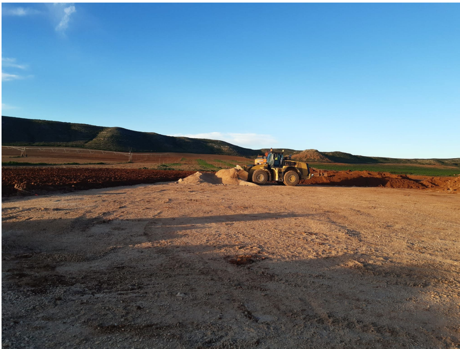
Foto 2: ejecución de restauración de plataforma.
