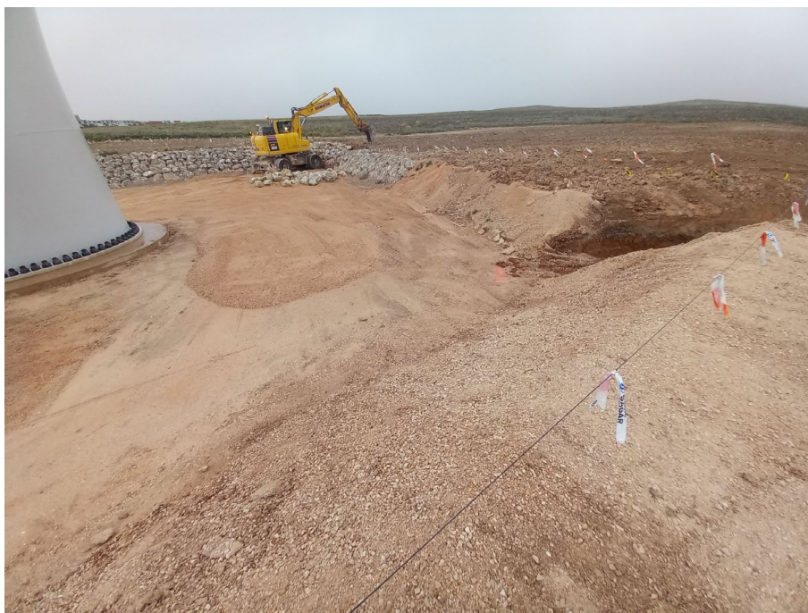
Foto 6: Trabajos de restauración en plataformas
