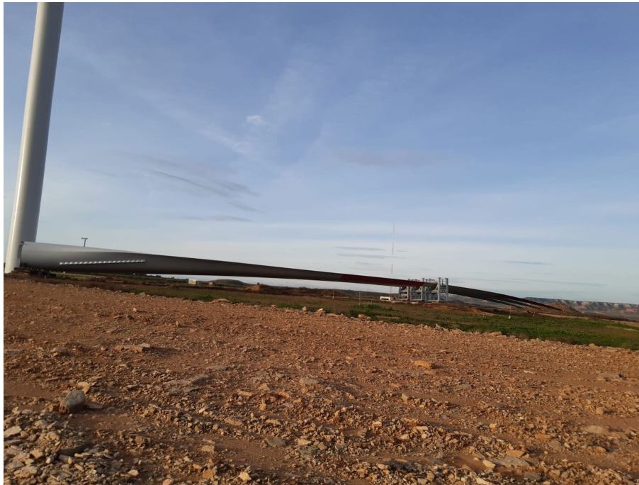
Foto 1: acopio de pala previo a instalación.
