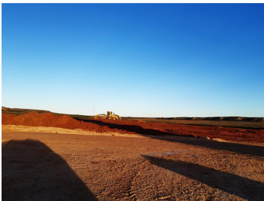
Foto 6: Trabajos de restauración en plataformas.
