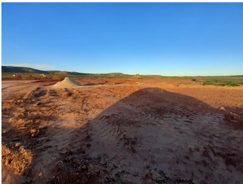
Foto 4: Trabajos de restauración en plataformas.
