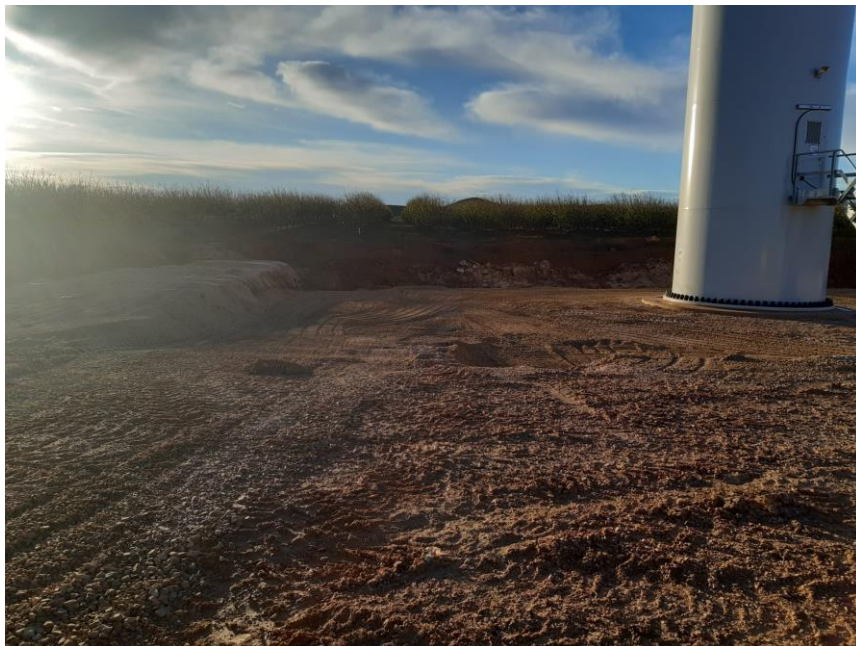
Foto 1: ejecución de restauración de plataforma del aerogenerador CN3-02.
