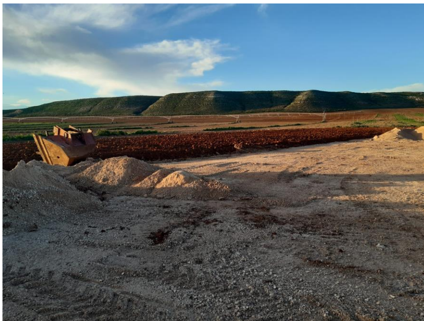
Foto 5: Trabajos de restauración en plataformas.
