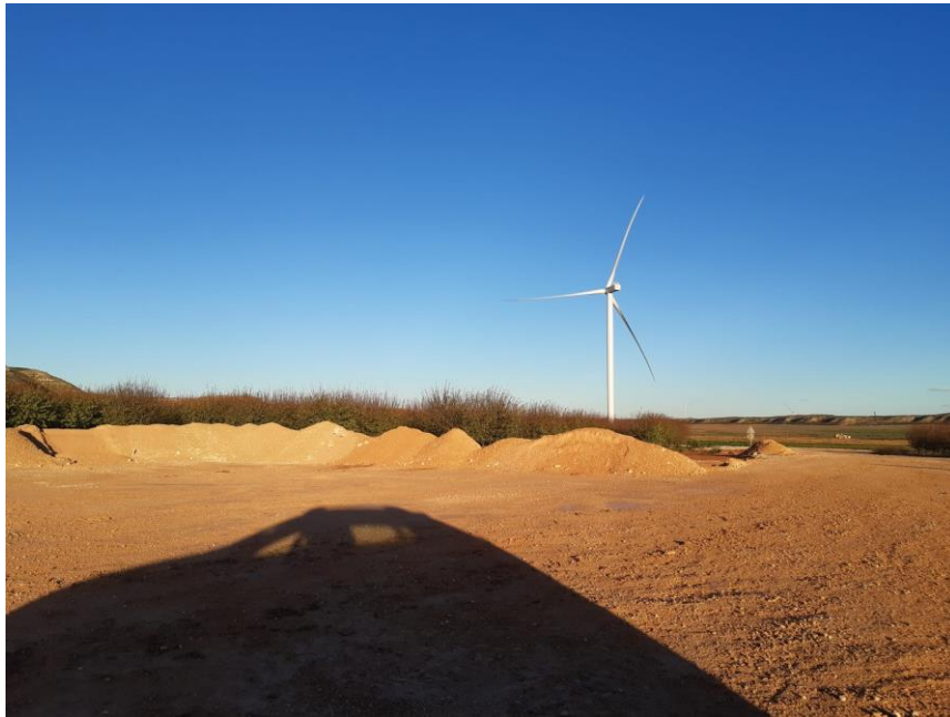
Foto 1: acopio de tierra vegetal para restauración de plataformas.
