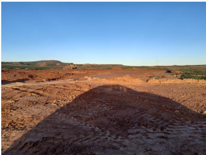
Foto 3: Trabajos de restauración en plataformas.
