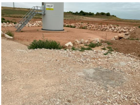
Restos de hormigón en el aero CN3-07 y restos de residuos en el sitecamp.
