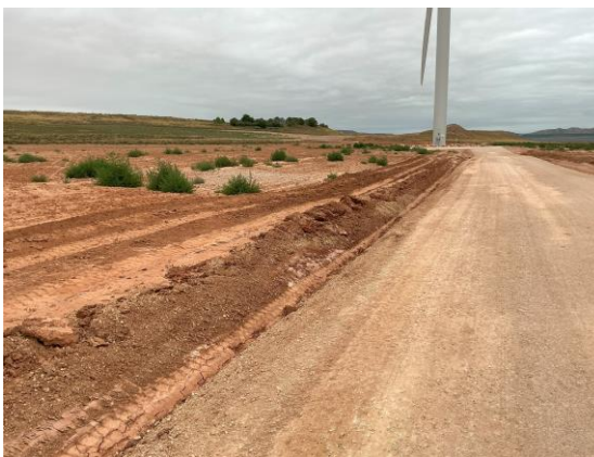
Margen derecha e izquierda en la finalización de drenajes en el aerogenerador CN3-07.
