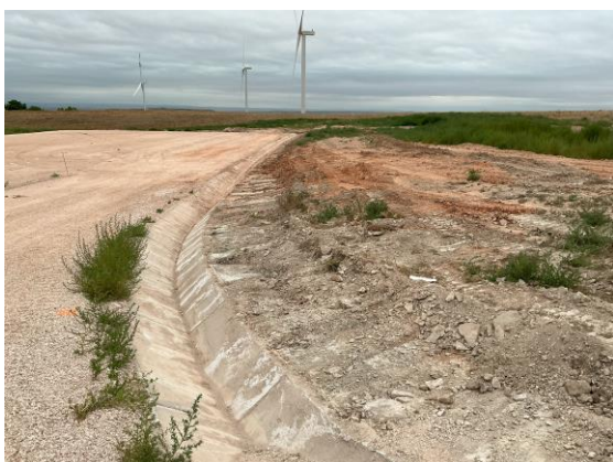
Ejecución de drenaje en aerogenerador CN3-05.
