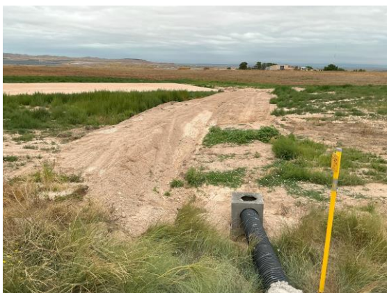
Ejecución de drenaje en aerogenerador CN3-05.
