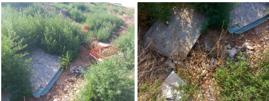
Restos de residuos en el site camp.
