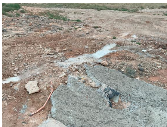
Trabajos finalizados en el barranco de Valdecara y restos de residuos de hormigón procedentes de los trabajos.
