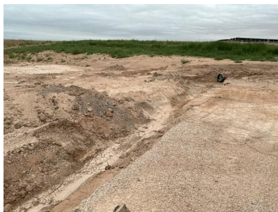
Ejecución de drenaje en aerogenerador CN3-05.
