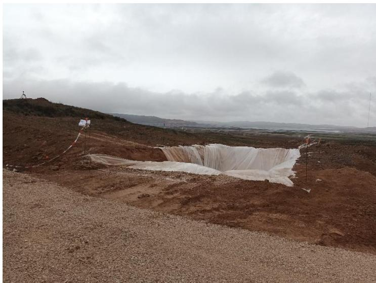
*Figura 2: Balsa de limpieza de cubas con plástico pendiente de recolocar al lado de CN3-04*
