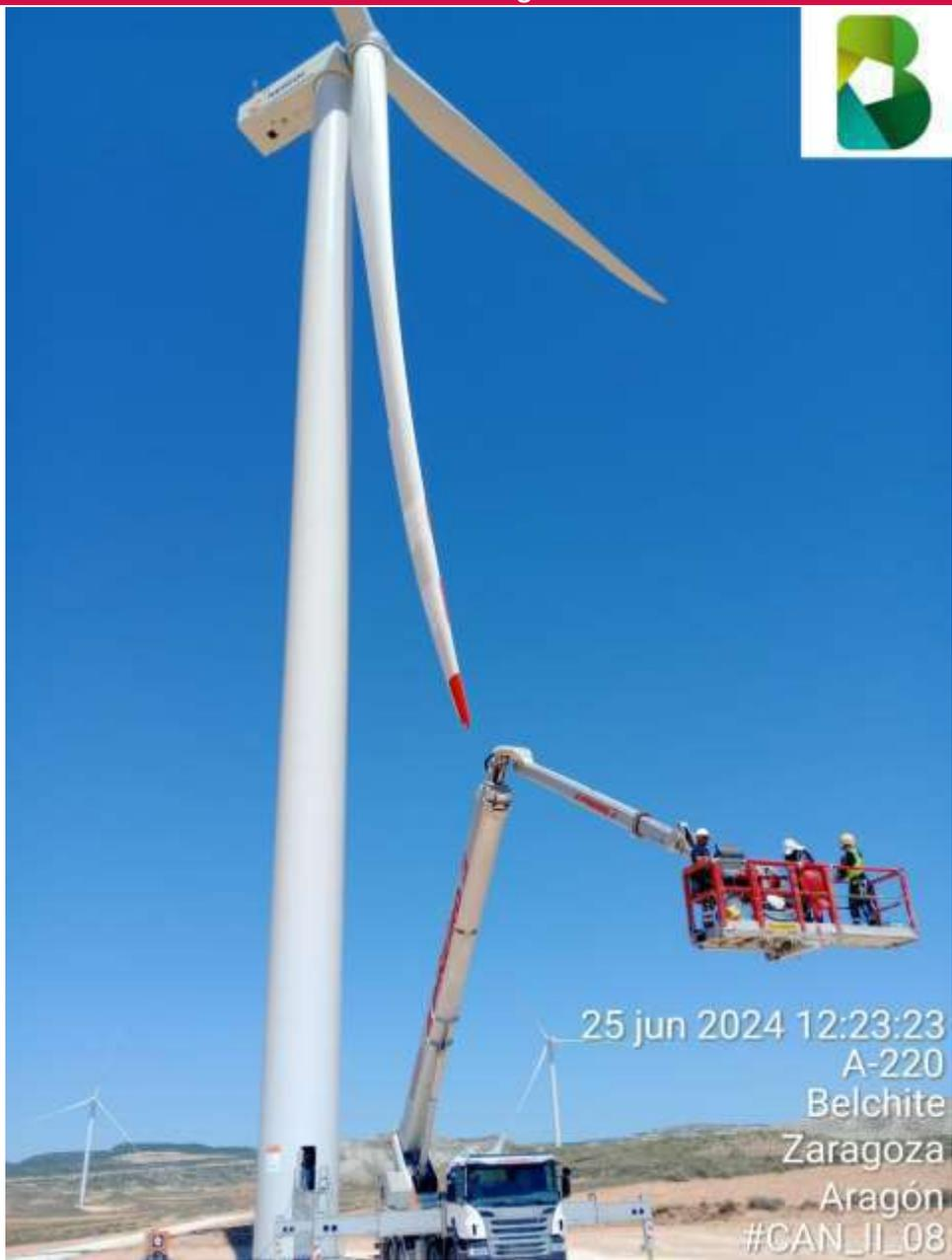
Imagen 1. Trabajos de pintado de palas en CAN2-08.
