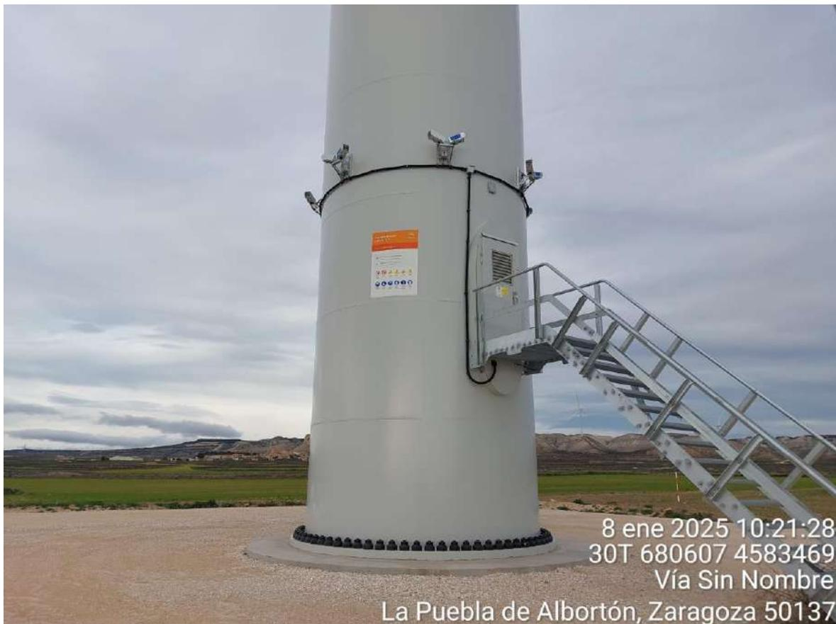
Imagen 1. Cámaras del sistema anti-colisión 3D-Observer.
