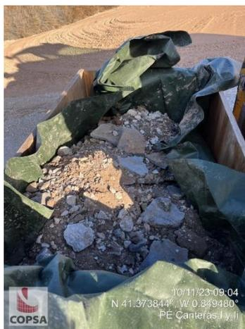
Material acopiado en la campa hasta su utilización en el relleno de la rampa de CAN I-02
