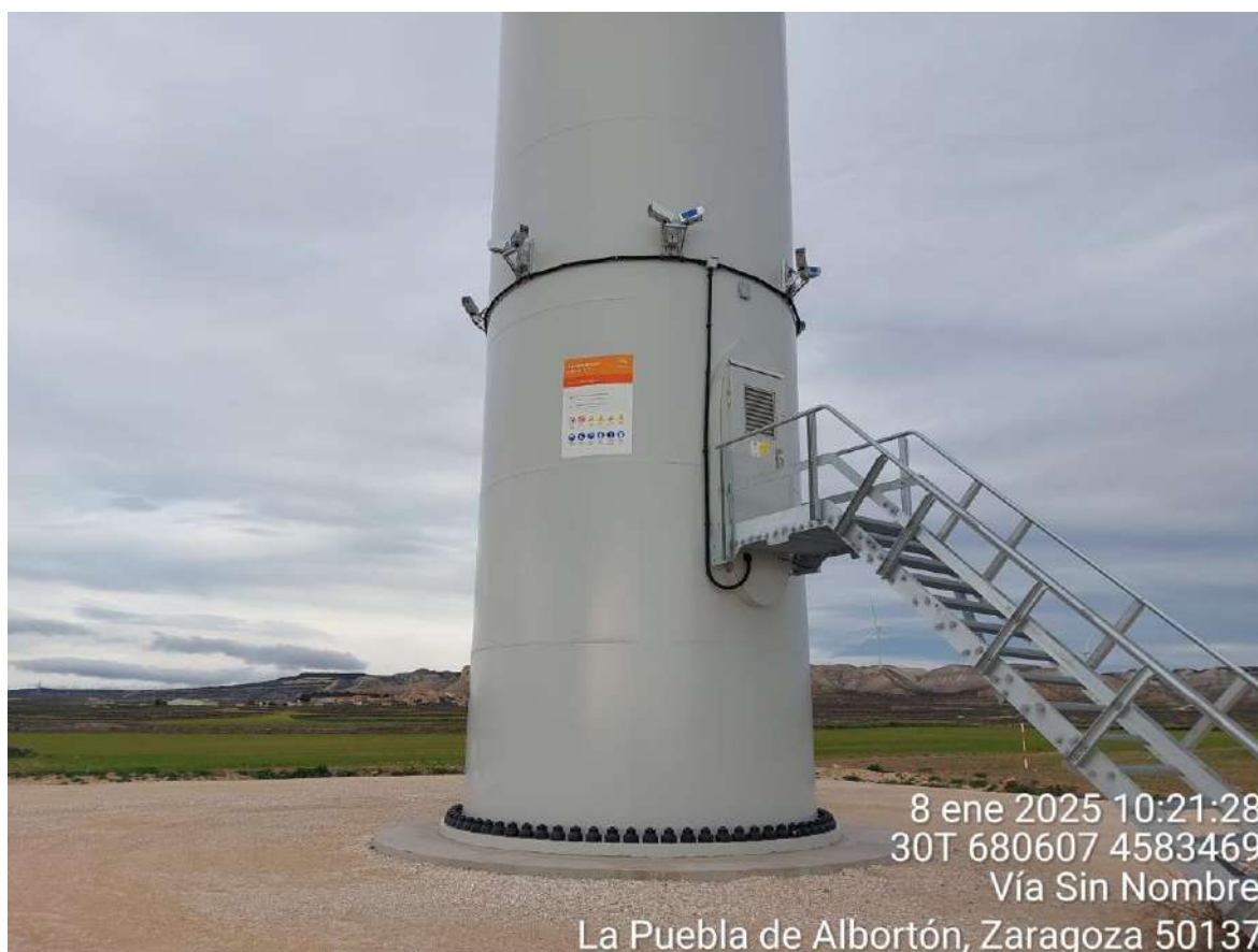
Imagen 1. Cámaras del sistema anti-colisión 3D-Observer.
