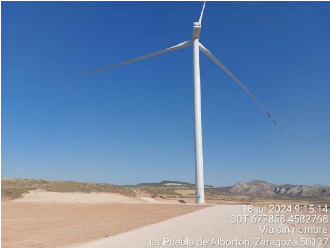
Imagen 1. Posición restaurada y finalizados los trabajos a falta de revegetación.
