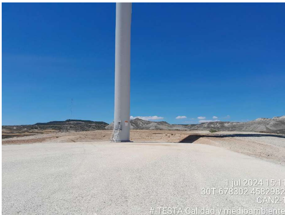
Imagen 2. Plataforma CAN2-1 restaurada
