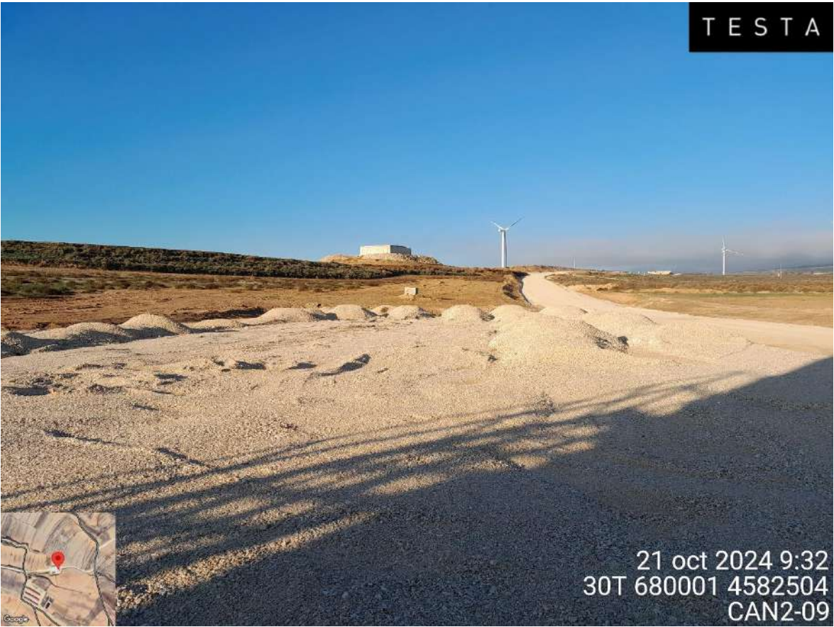
Imagen 1. Zahorra acopiada en la plataforma CAN2-09 para ser distribuida durante la restauración
