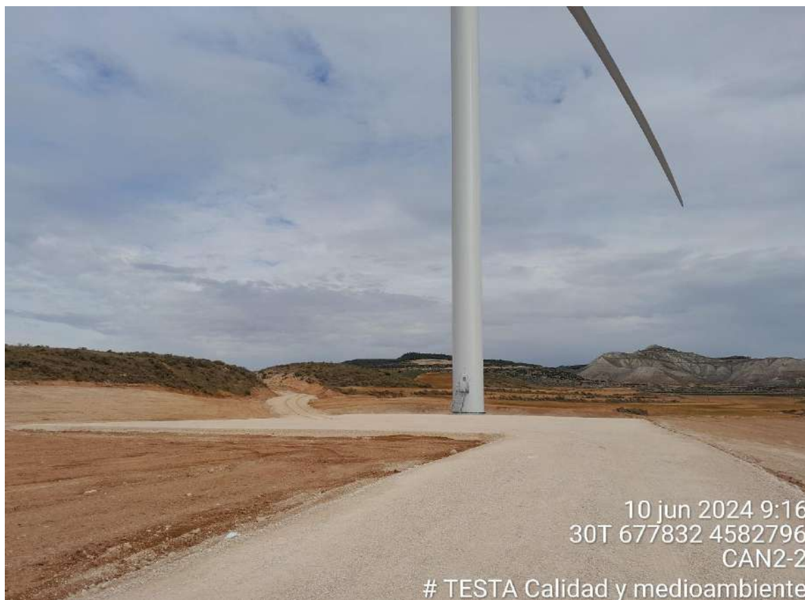
Imagen 1. Plataforma CAN2-2 restaurada
