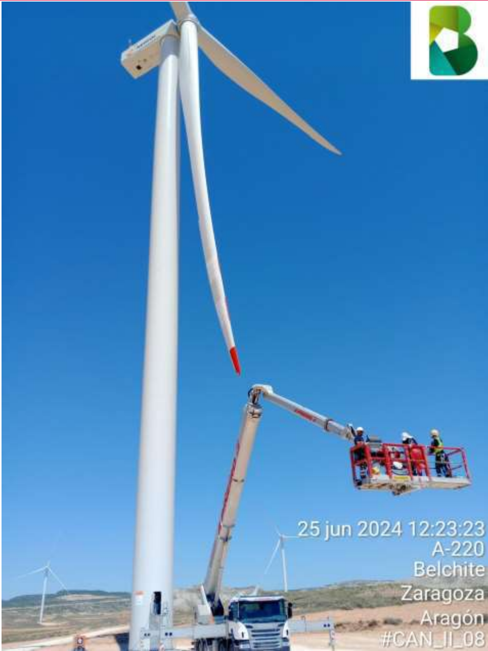
Imagen 1. Trabajos de pintado de palas en CAN2-08.
