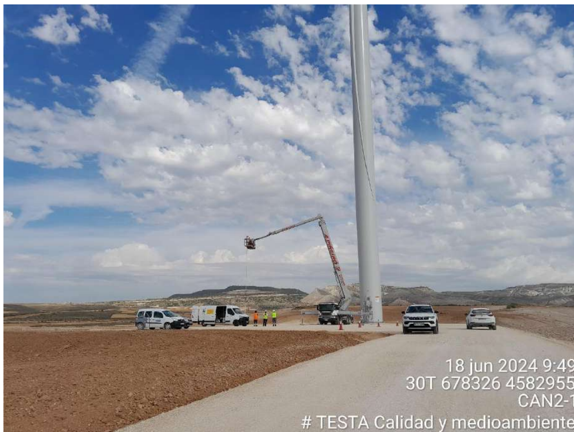
Imagen 1. Reparación de palas de CAN2-1
