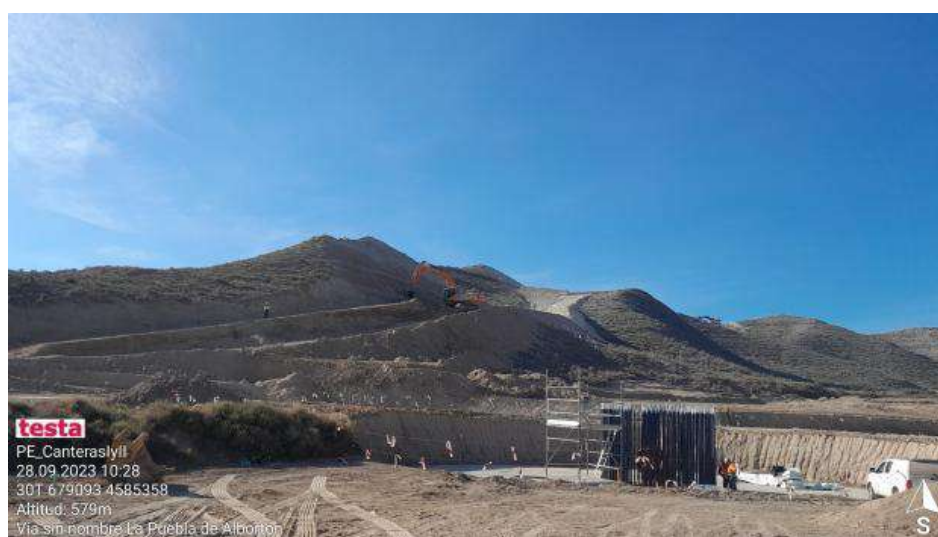
Cimentación de CNI-8 y acceso a CN1-2
