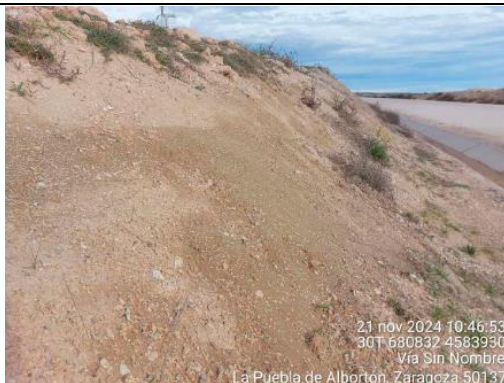
Hidrosiembra en talud
