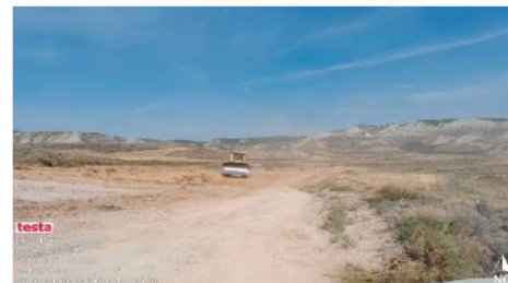
Apertura viales y estaquillados
