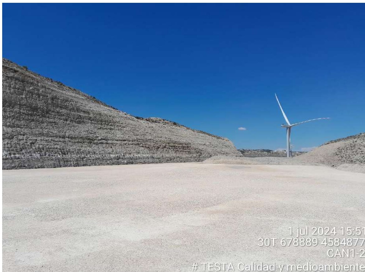
Imagen 2. Plataforma CAN1-2 restaurada
