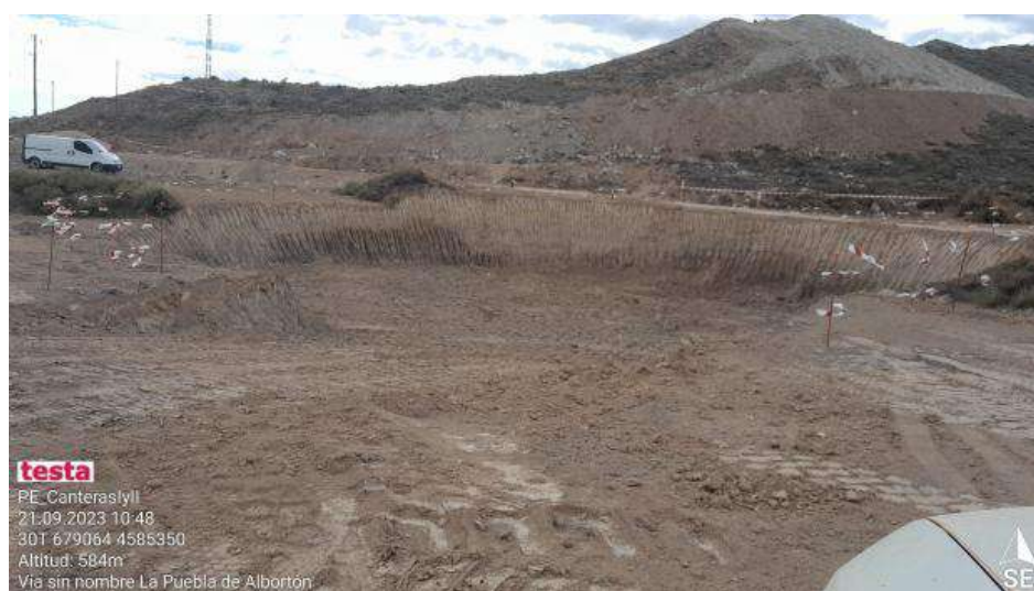
Cimentación de CNI-8
