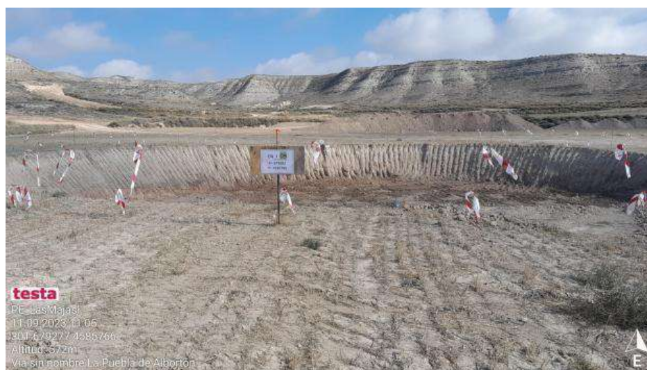
Apertura de cimentación CNT1-9
