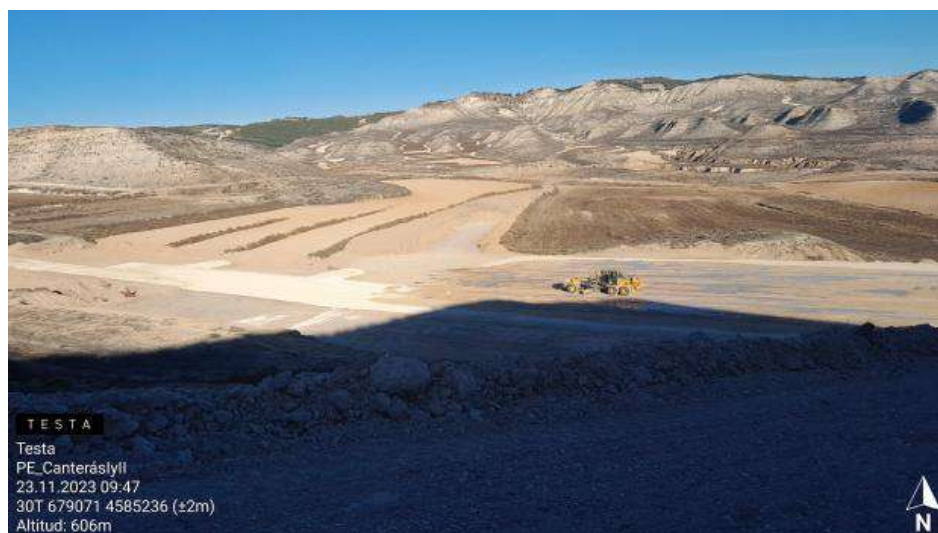
Extendido de zavorra CNT1-08
