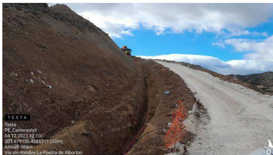
Tendido de cable en acceso a CNT1-2
