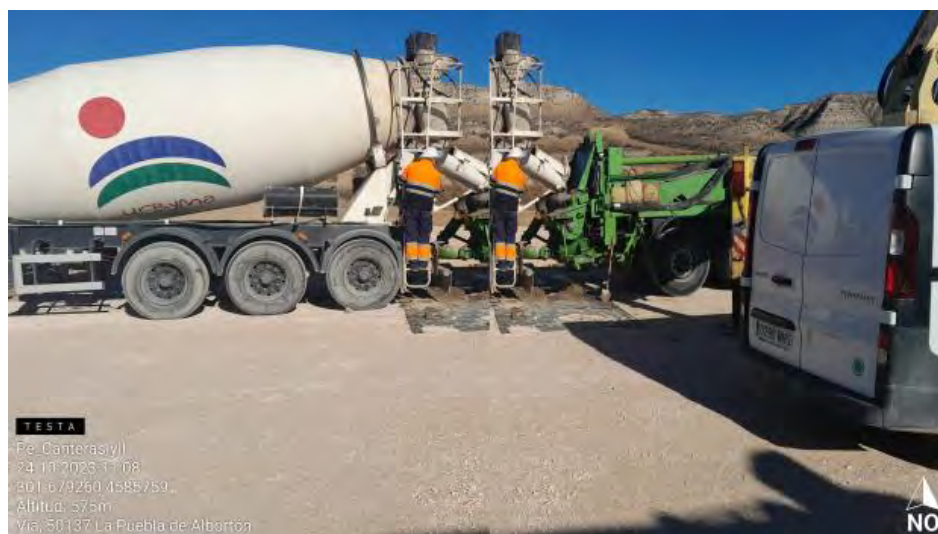
Hormigonado en CN1-9
