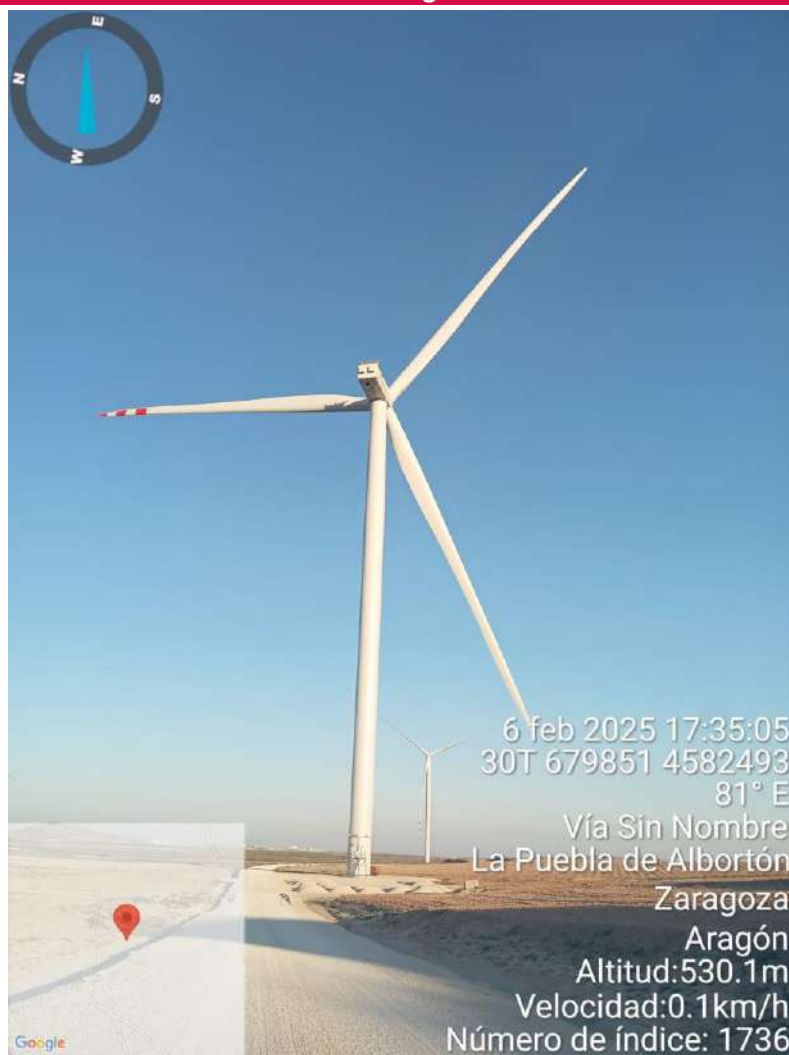
Imagen 1. CAN2-09 con las zahorras acopiadas y el 3D Observer instalado.
