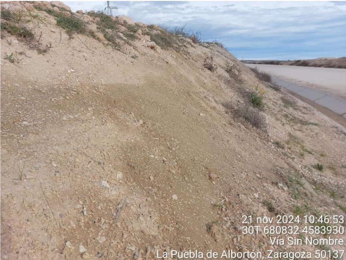
Imagen 1. Hidrosiembra realizada en talud de Canteras I.
