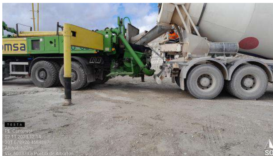
Hormigonado limpieza en CN1-2
