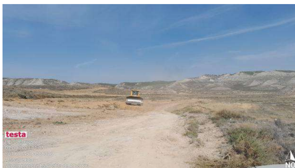
Apertura de viales y estaquillados .
