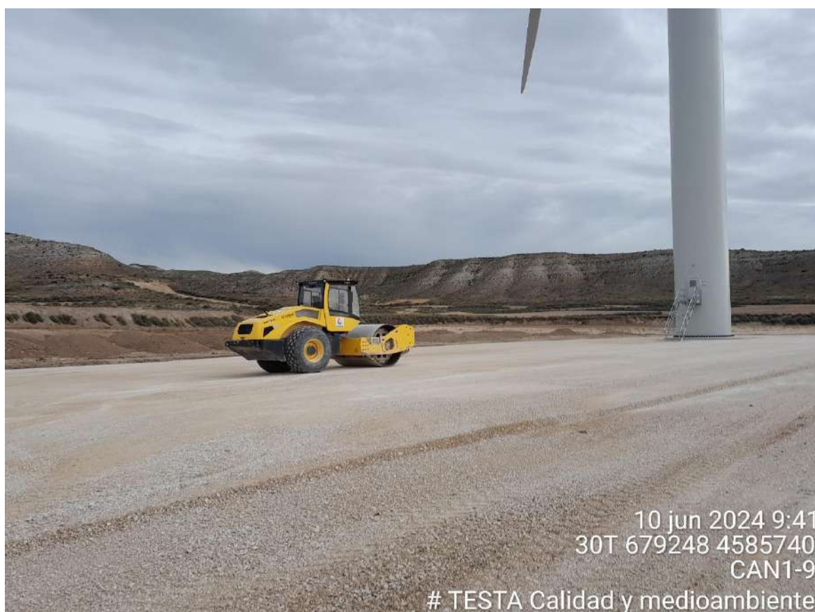
Imagen 2. Restauración de la Plataforma CAN1-9
