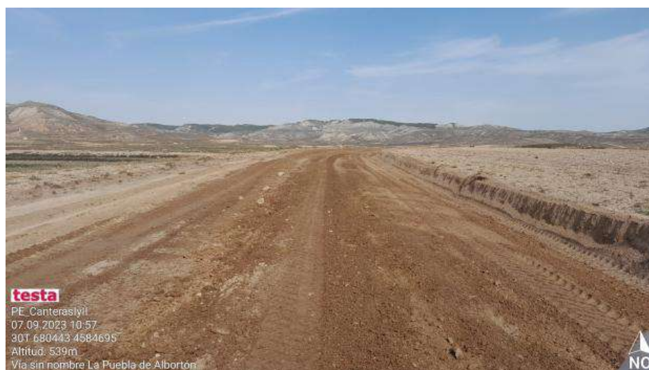
Apertura de viales con riegos.
