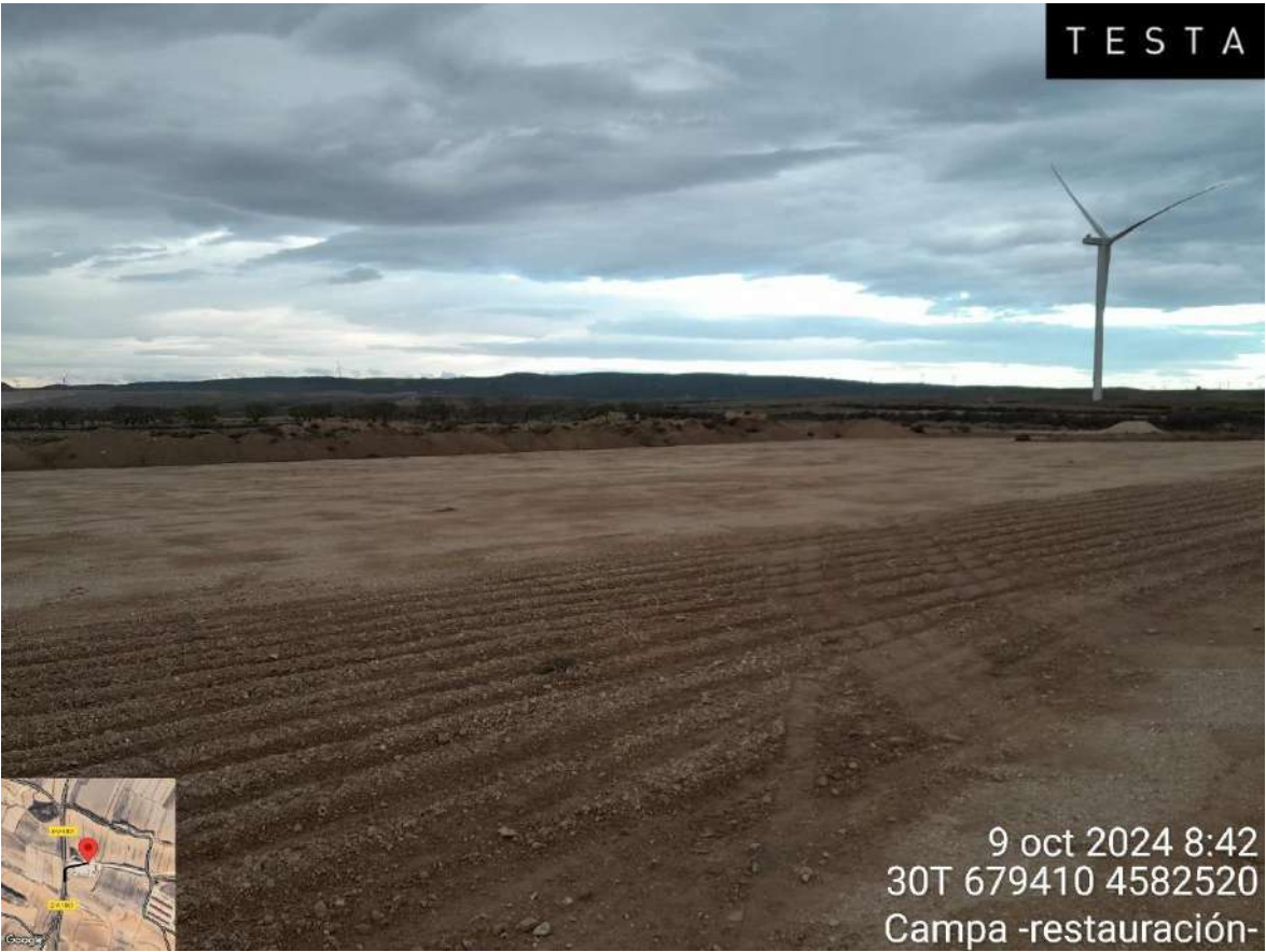
Imagen 1. Imagen panorámica de la campa de acopio restaurada
