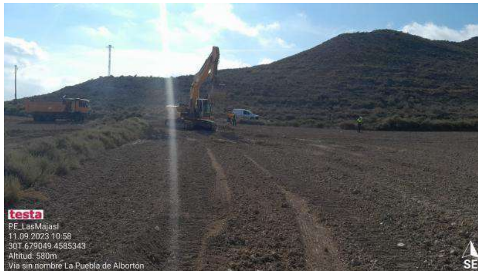
Estaquillados y primeros trabajos en CNT1- 8
