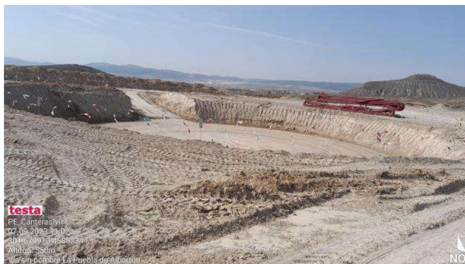
Primera cimentación abierta.
