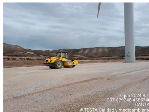
Trabajos restauración plataforma CANI-09
