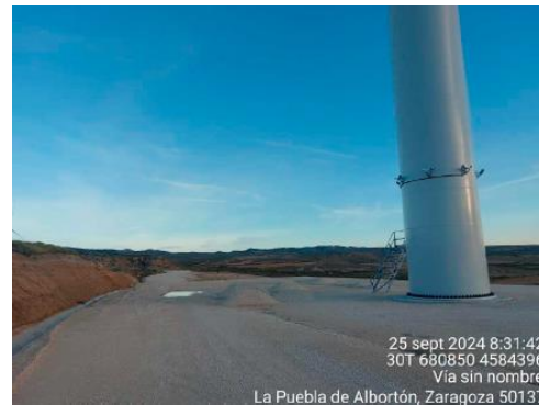
Zahorra campa acopiada para extendido en plataformas y viales
