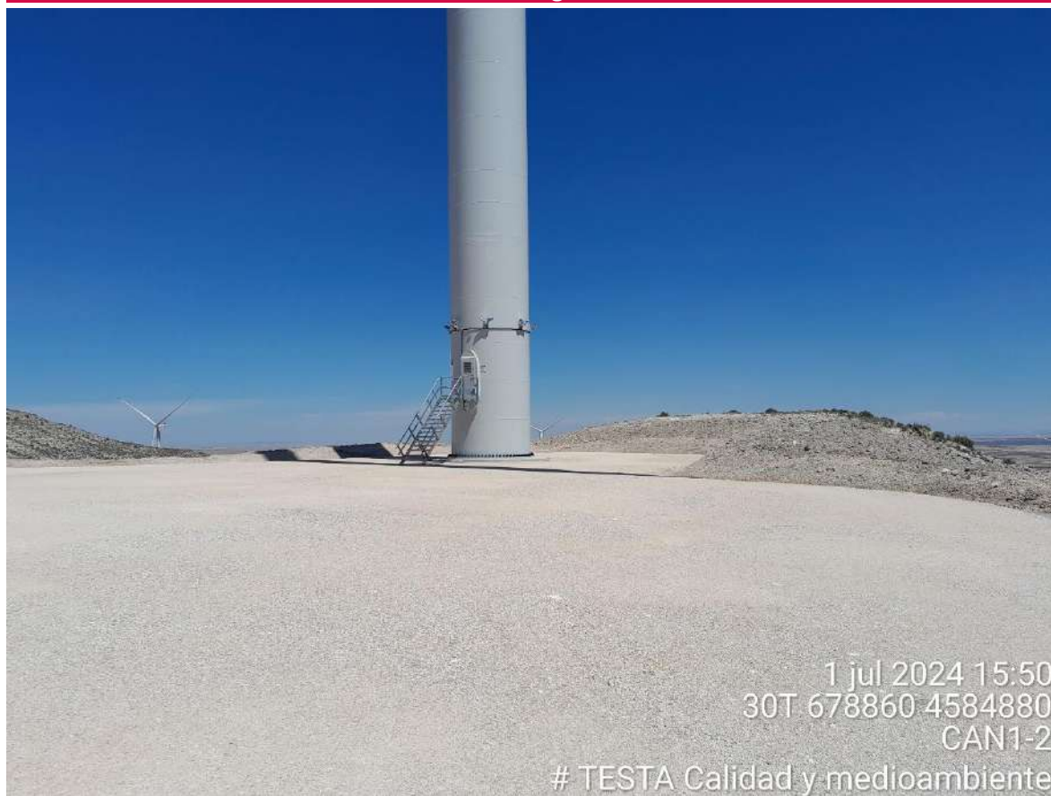
Imagen 1. Plataforma CAN1-2 restaurada
