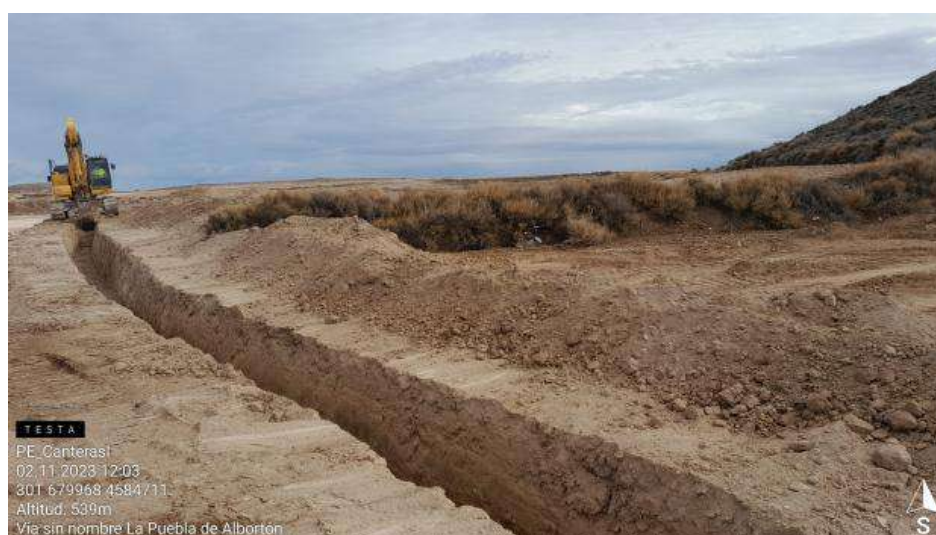
Zanja de evacuación en CN1-6 sin separación de tierras .
