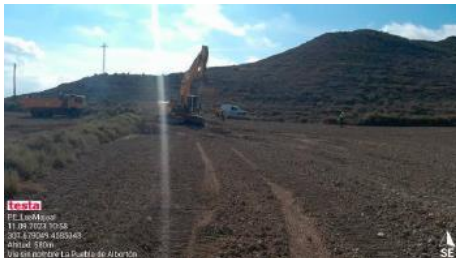
Estaquillado y primeros trabajos en CANI-08
