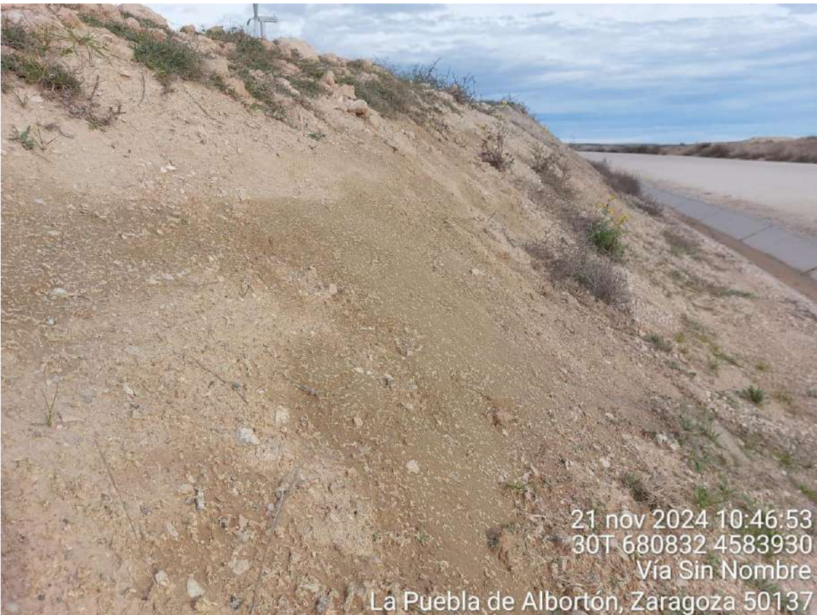
Imagen 1. Hidrosiembra realizada en talud de Canteras I.
