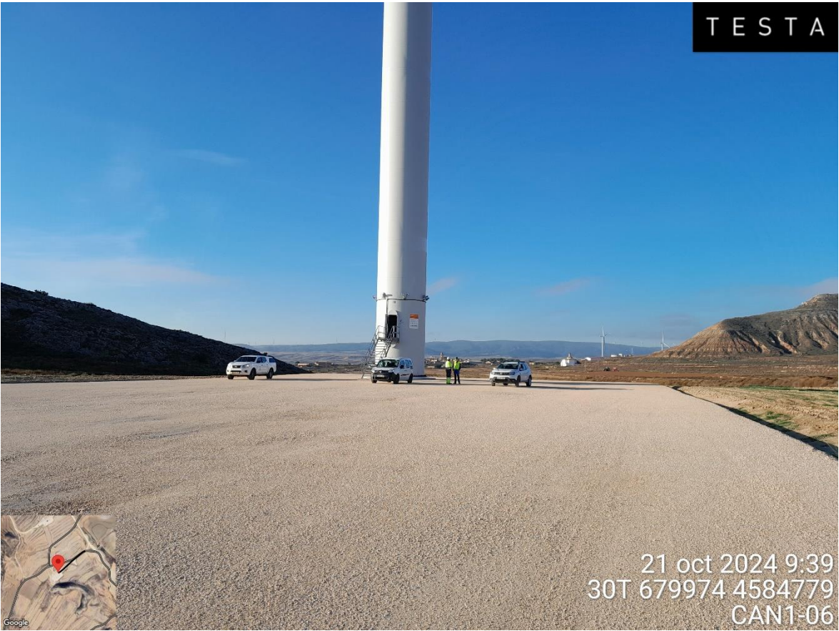
Imagen 1. Trabajos internos en el aerogenerador CAN1-06
