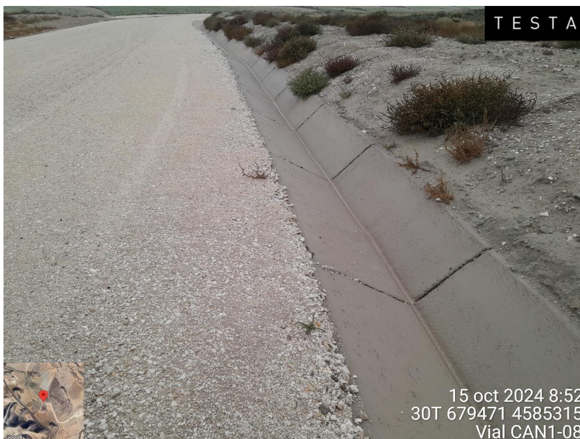
Imagen 1. Cuneta del vial de acceso a la posición CAN1-08
