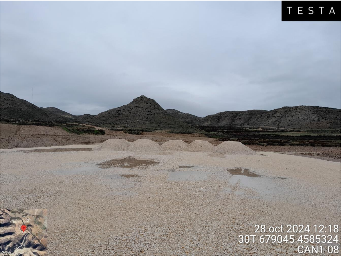
Imagen 1. Acopio de zahorra en la plataforma CAN1-08, para su distribución durante la restauración del parque
