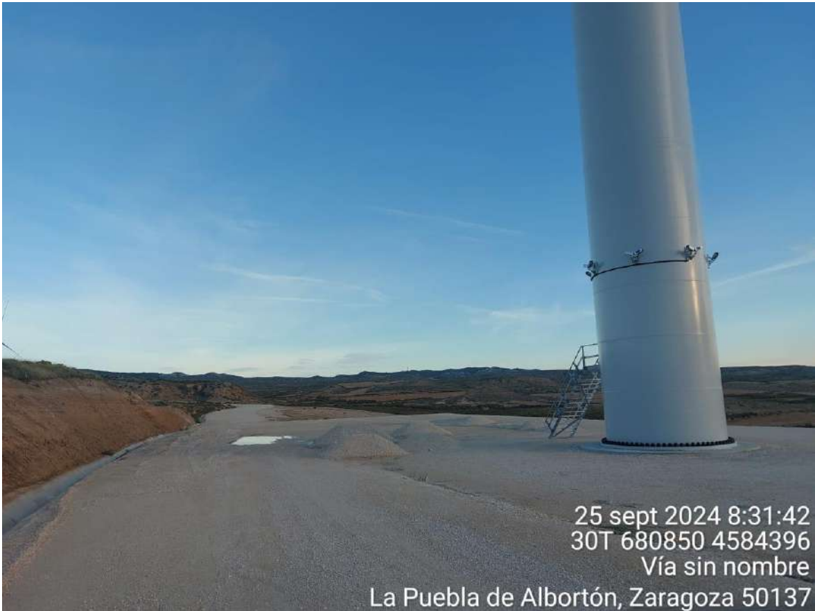
Imagen 1. Zahorra de la campa acopiada para extendido en plataformas y viales.
