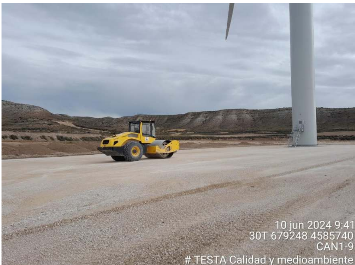
Imagen 2. Restauración de la Plataforma CAN1-9
