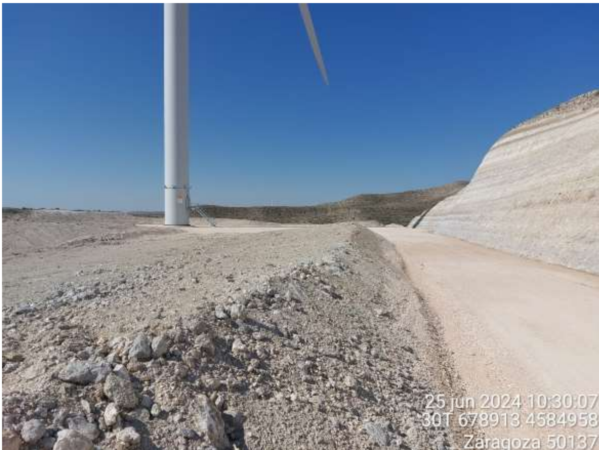
Imagen 2. CAN1-02 tras realizar los trabajos de restauración morfológica.
