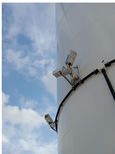
Fotografías 12 a 15. Señalización de las torres de los aerogeneradores y 3D Observer.
