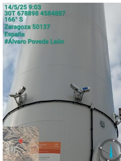
Fotografías 12 a 15. Señalización de las torres de los aerogeneradores y 3D Observer.
